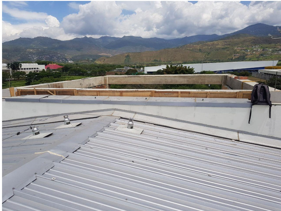
Imagen 21. Ubicación de la cubierta
