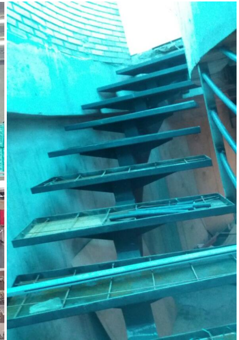
imagen 10. Detalle escalón
