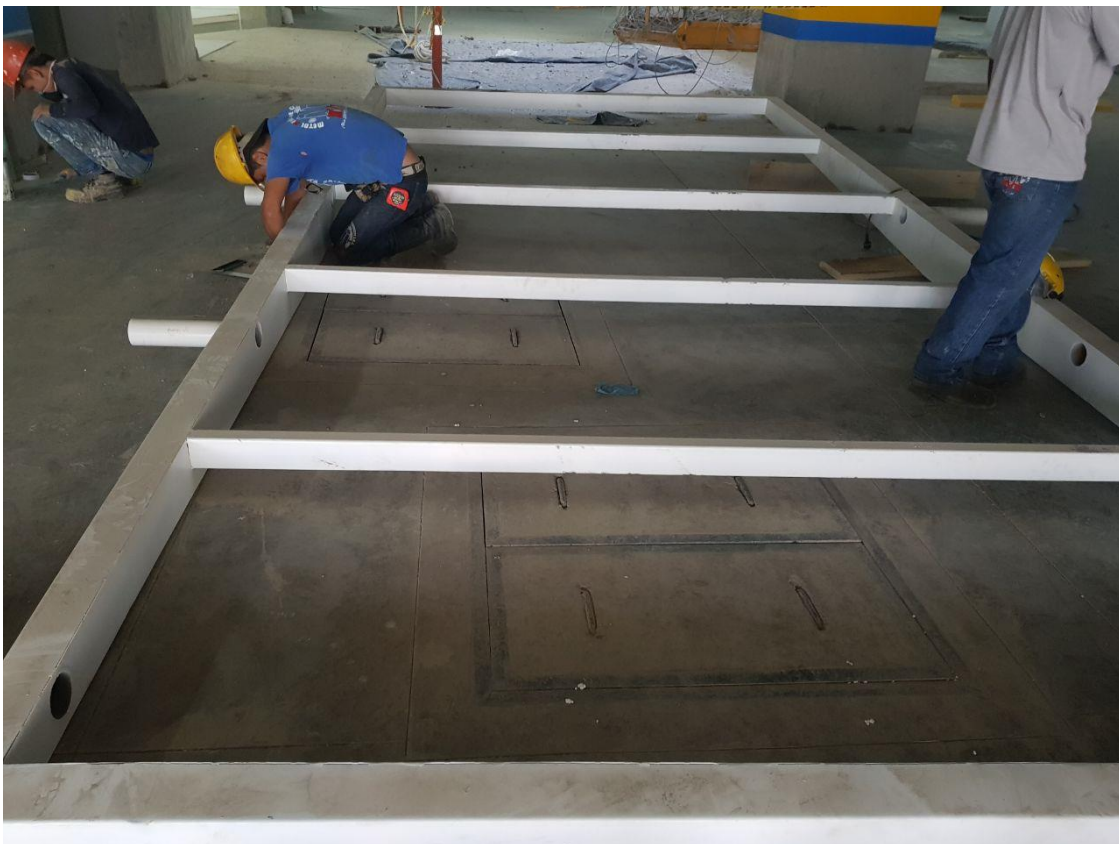
Imagen 18. Preparando la pérgola para trasladarla al lugar del montaje
