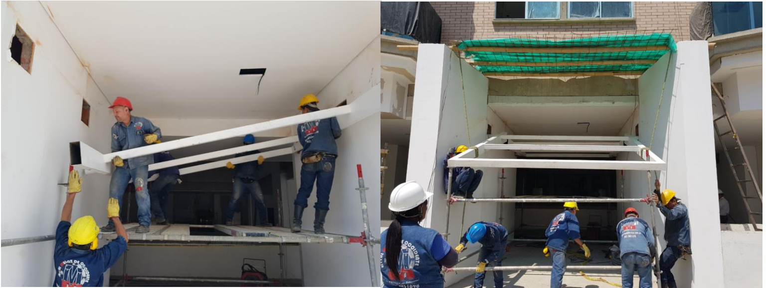
Imagen 19. Instalación de la pérgola
