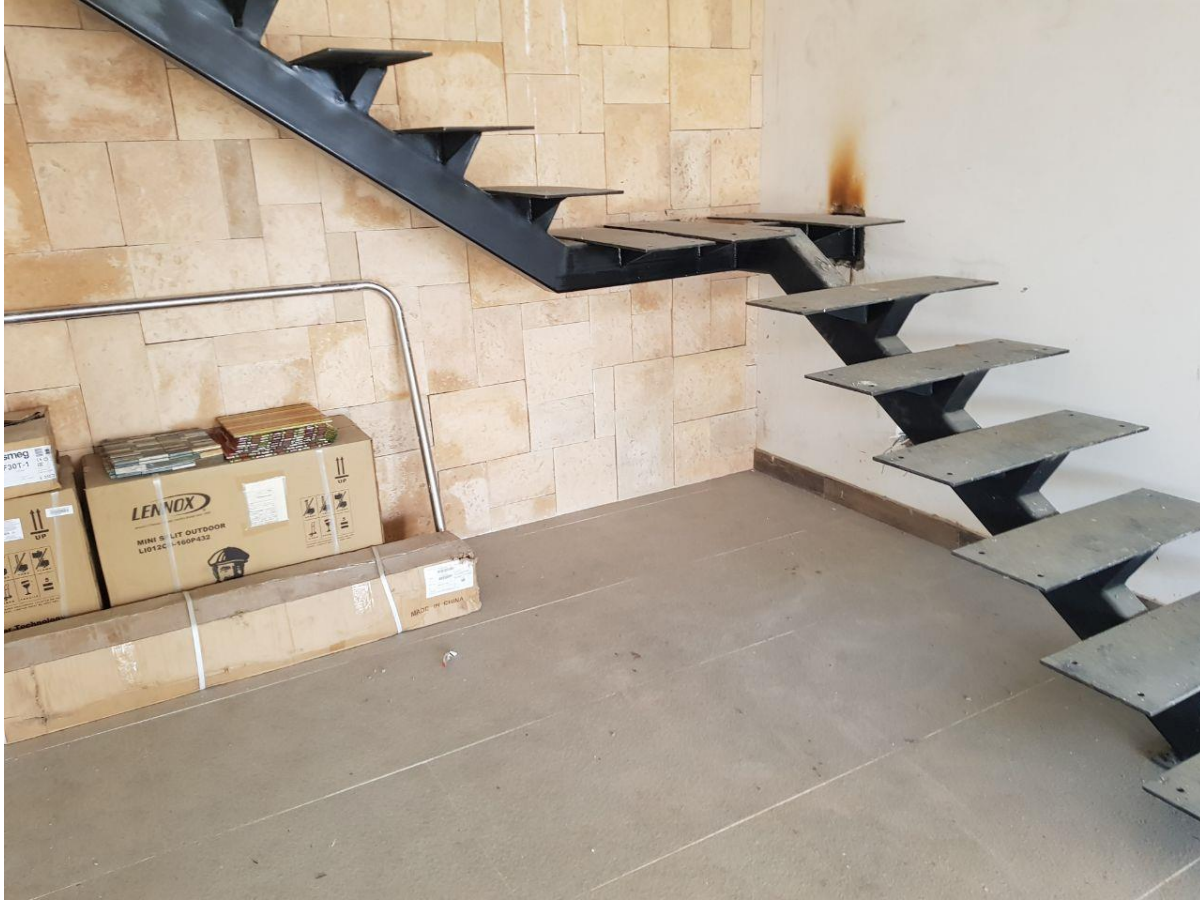
Imagen 7. Instalación de la escalera
