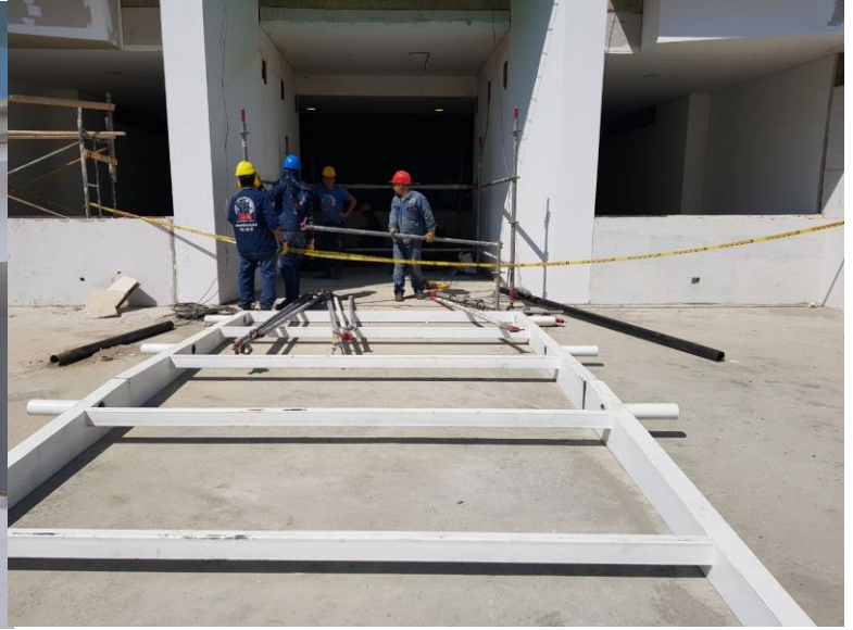
imagen 17. Pérgola situada en el lugar de montaje
