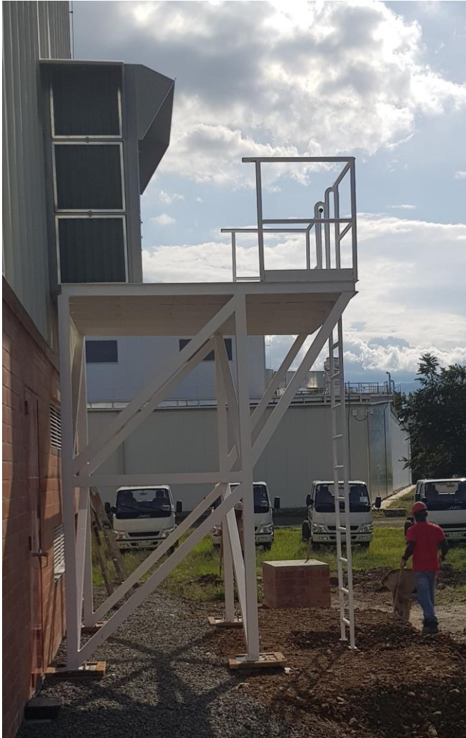
imagen 1. Plataforma filtro de extracción 1 (sweetsol)
