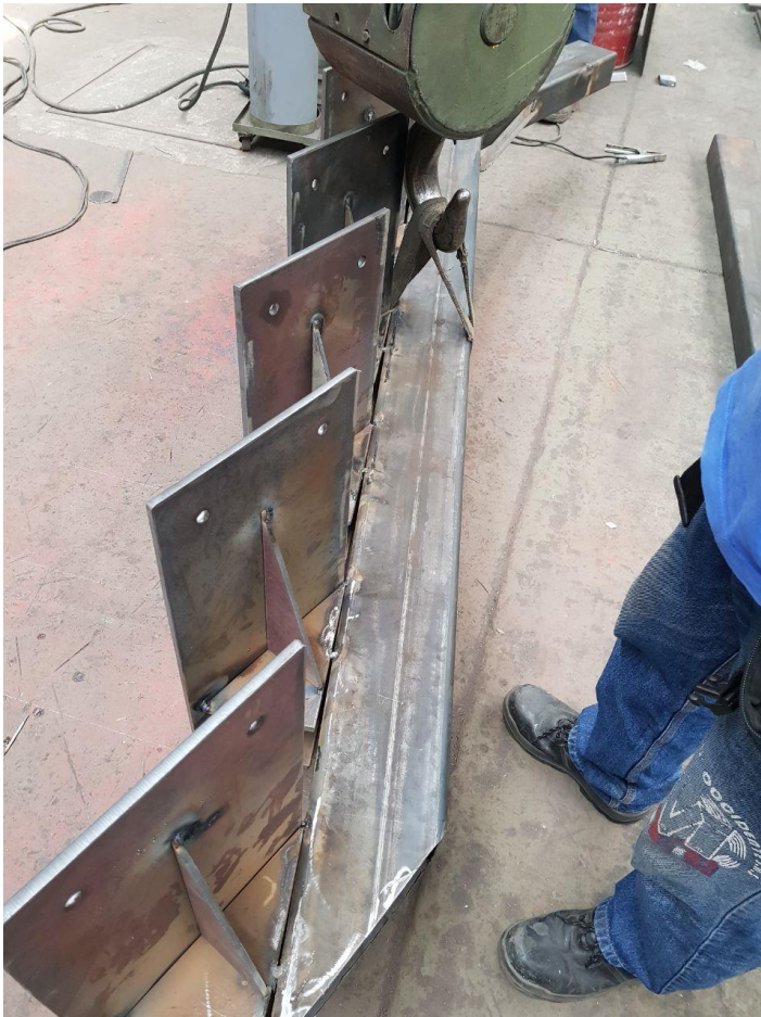
imagen 5. Fabricación primer tramo en planta
