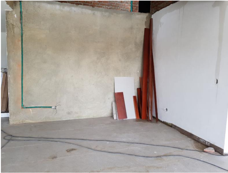
Imagen 3. Sitio de instalación de la escalera
