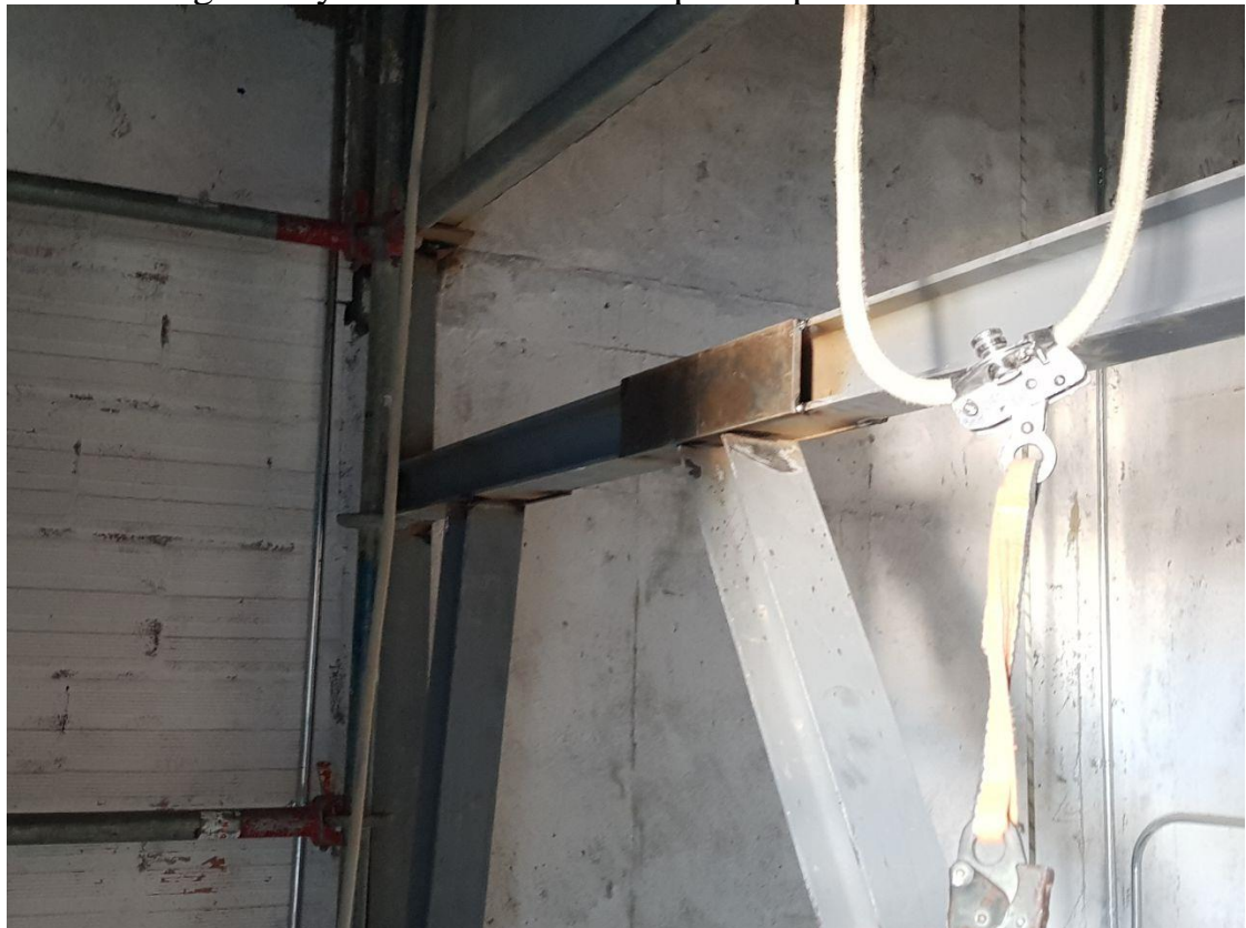
Imagen 38 y 39. Detalle de tornapuntas para refuerzo
