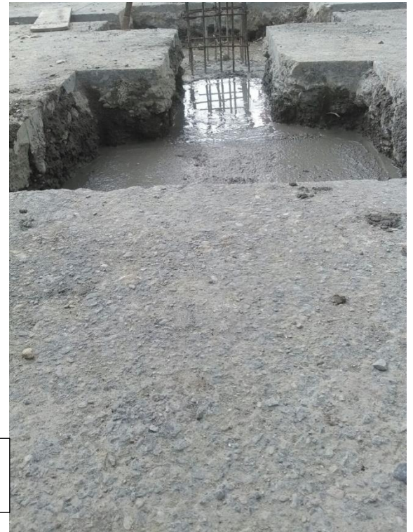
Fundición de zapatas y pedestales
