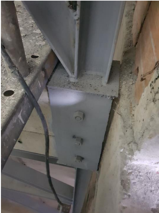
Imagen 36y 37. Detalles de anclajes a vigas existentes en concreto
