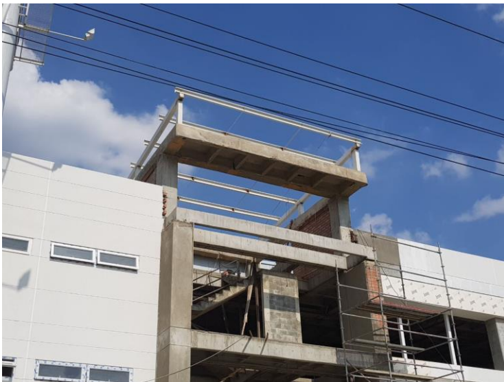
Imagen 26. Vista desde el primer piso (instalación de contravientos y tensores oblicuos)
