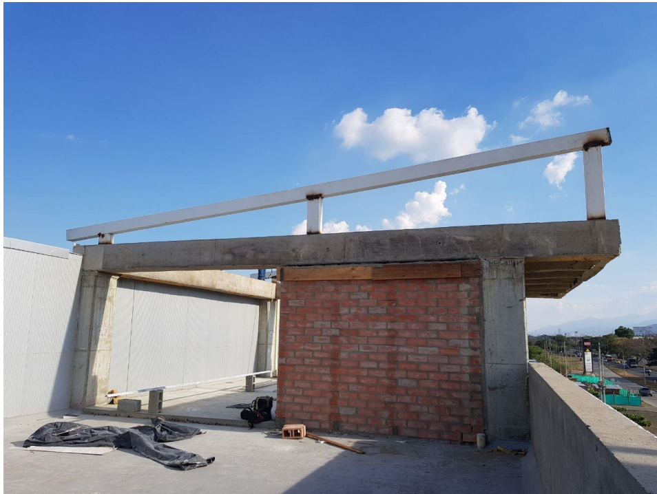
Imagen 22. Fase 2 del montaje de la cubierta
