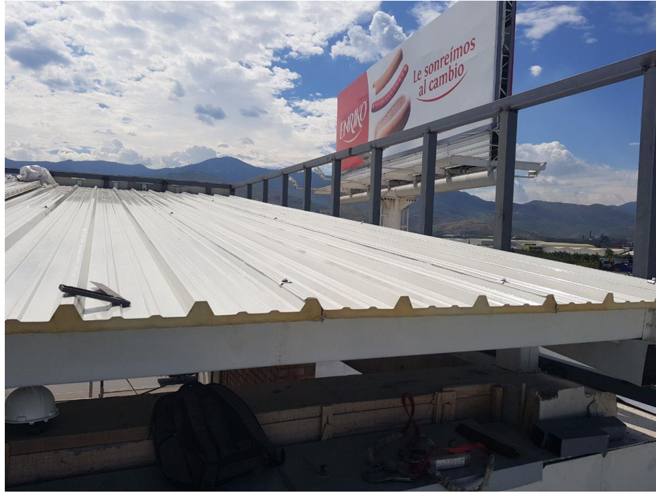
Imagen 28 y 29. Fase 5 del montaje instalación de teja meTecno
