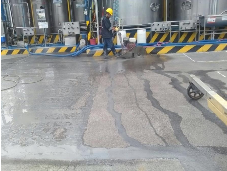
Corte v demolición de Pavimento
