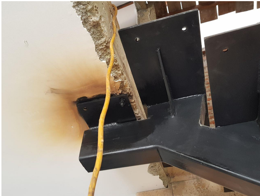
Imagen 8. Detalle anclaje superior escalera
