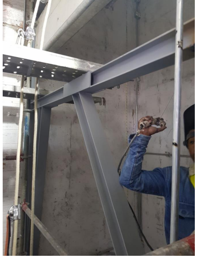
Imagen 34 y 35. Detalles de pintura y platina para apoyo del ascensor
