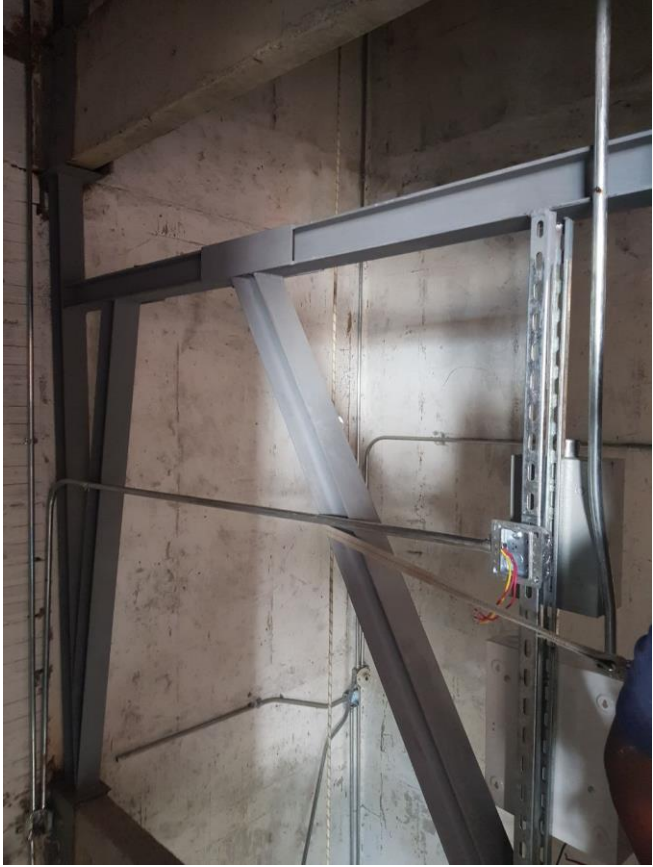
Imagen 34 y 35. Detalles de pintura y platina para apoyo del ascensor
