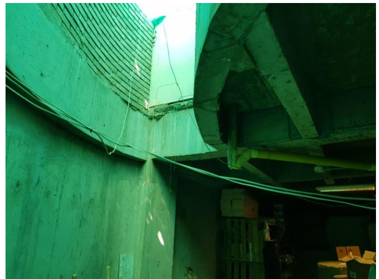
Imagen 12. Sitio donde se instalaría La escalera
