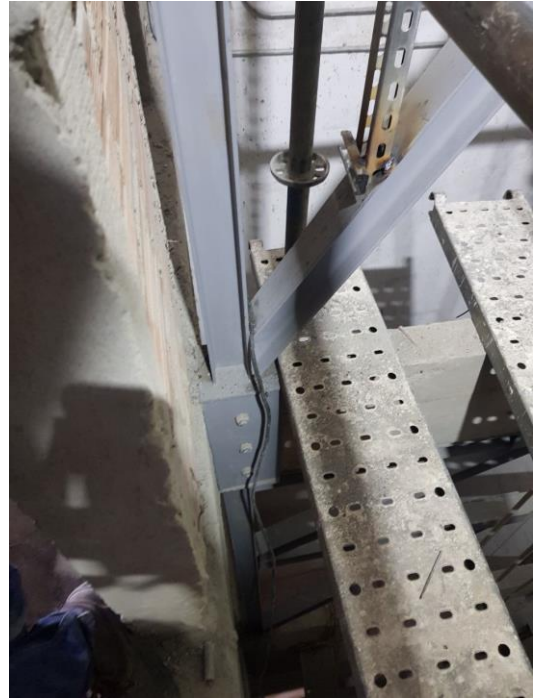
Imagen 36y 37. Detalles de anclajes a vigas existentes en concreto
