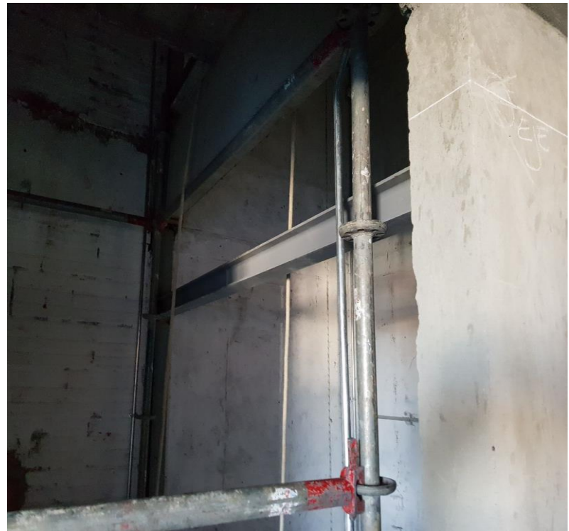
Imagen 32 y 33. Instalación de vigas
