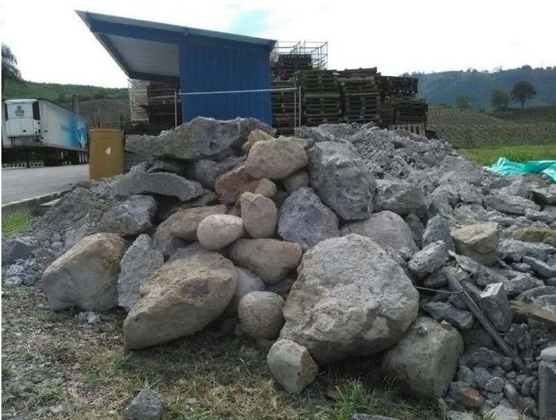
Excavación y retiro de escombros
