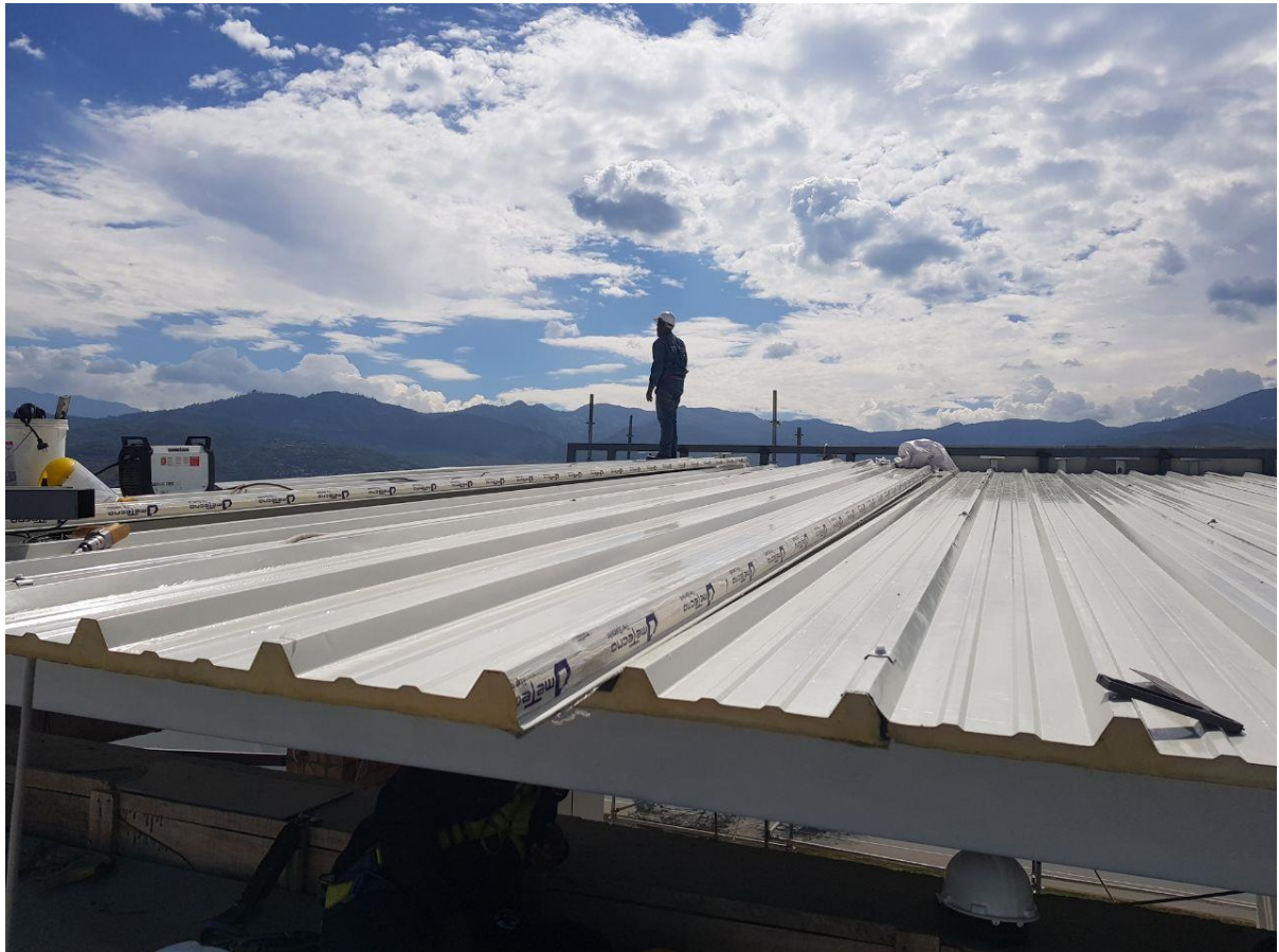
Imagen 28 y 29. Fase 5 del montaje instalación de teja meTecno
