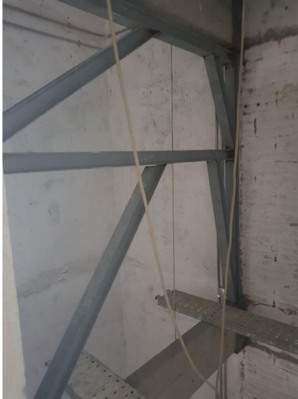
Imagen 38 y 39. Detalle de tornapuntas para refuerzo
