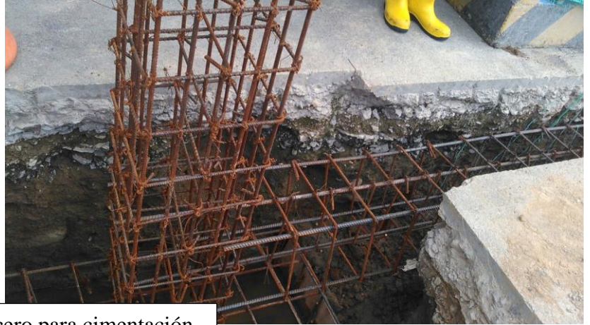
Figurado del acero para cimentación
