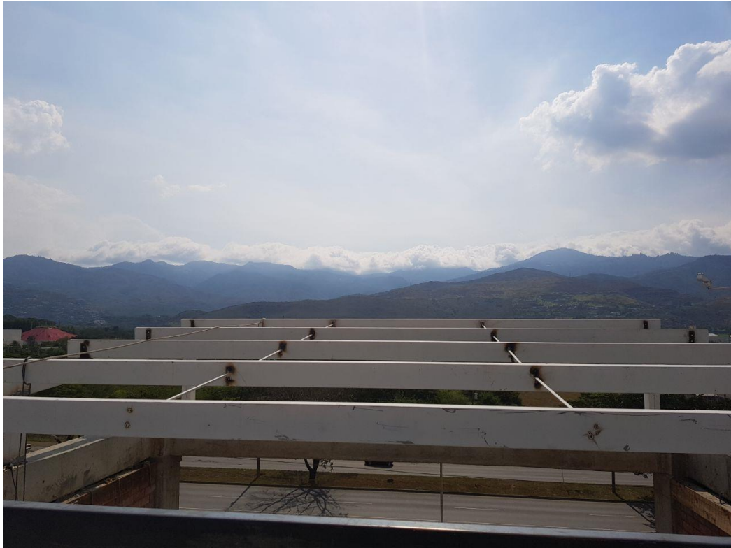
Imagen 25. Fase 3 del montaje (instalación de correas y tensores)
