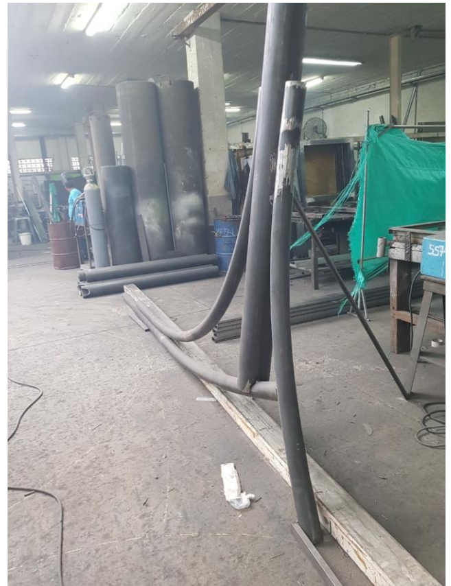
Imagen 14 y 15. Fabricación de Pórticos en la planta
