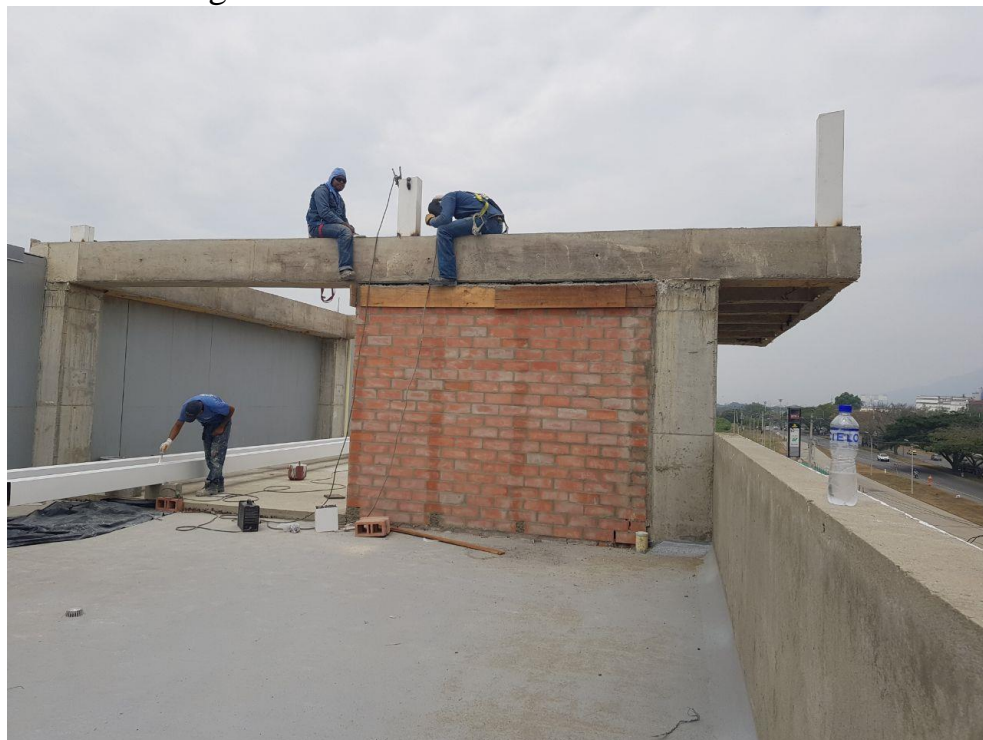
Imagen 22. Fase 1 del montaje de la cubierta
