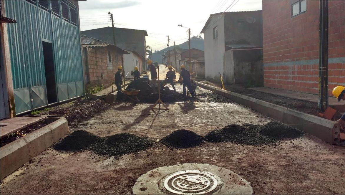
Fotografía 7 Extendido a mano base granular.
