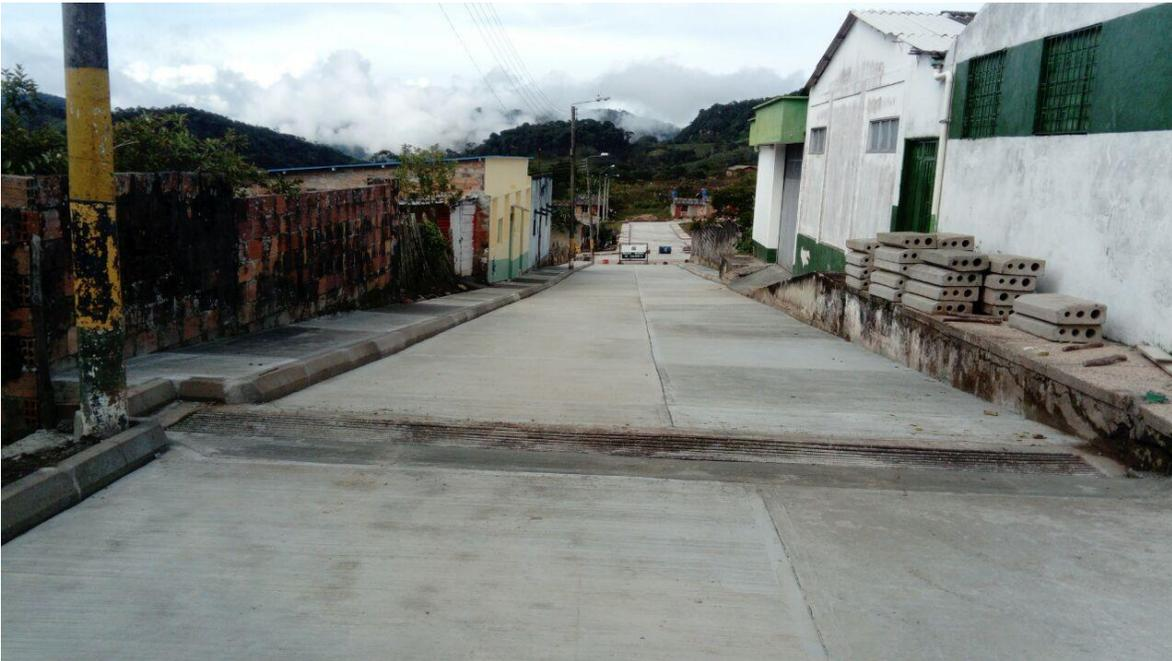
Fotografía 76 Construcción lozas de concreto tramo 6
