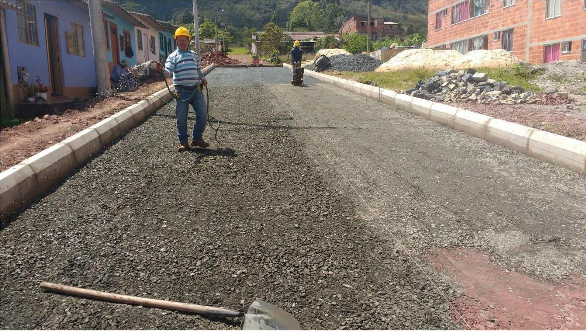
Fotografía 33 Extendido y compactación Base granular.
