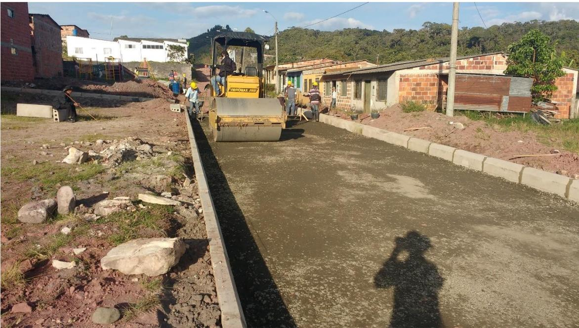
Fotografía 49 Extendido y compactación base granular.
