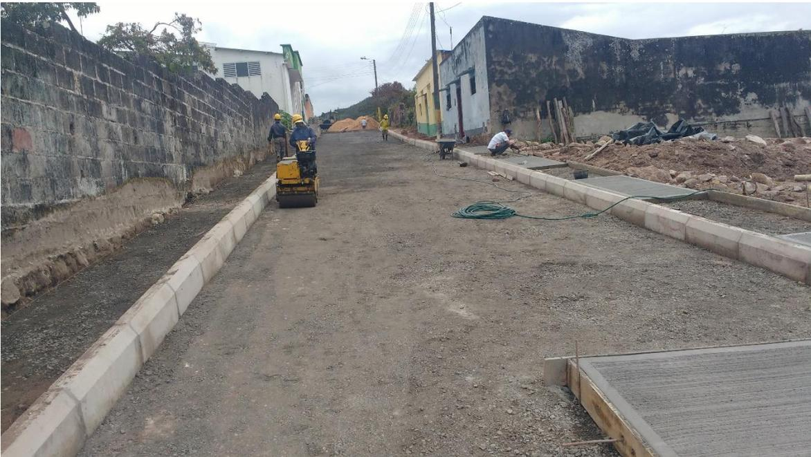
Fotografía 74 Extendido y compactación Base granular.
