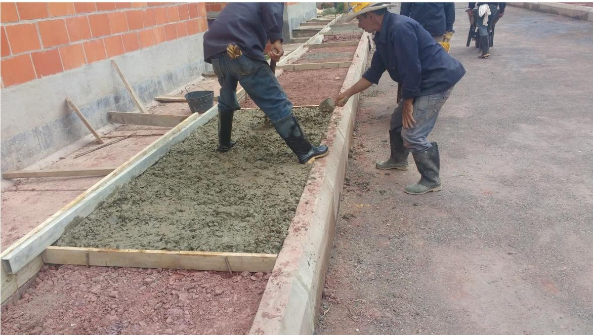
Fotografía 12 Vaciado concreto y nivelación.
