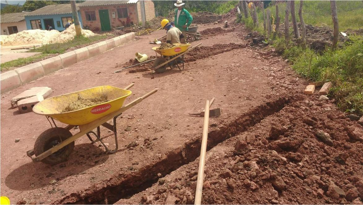
Fotografía 26 Conexiones de alcantarillado.
