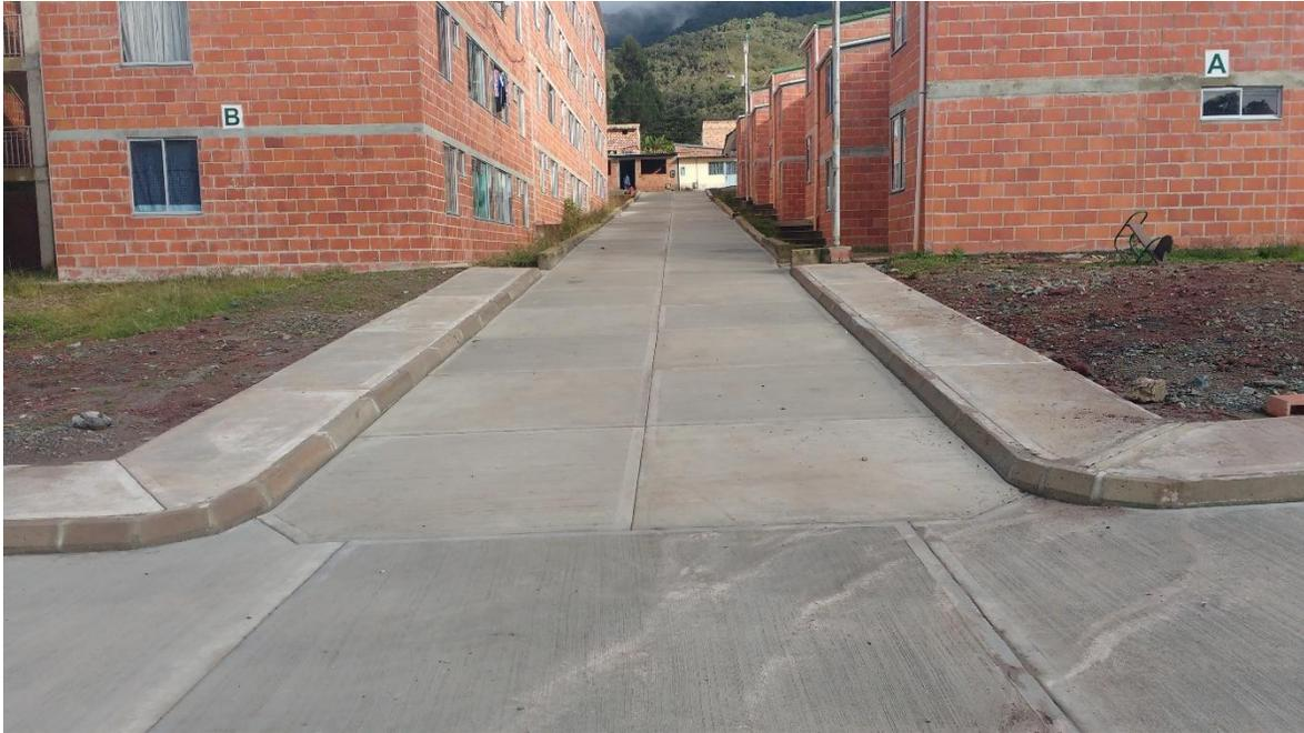
Fotografía 61 Construcción lozas de concreto tramo 4.
