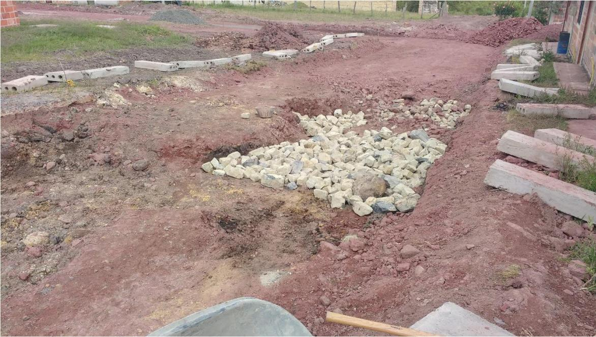
Fotografía 39 Excavaciones y reemplazo de material saturado.
