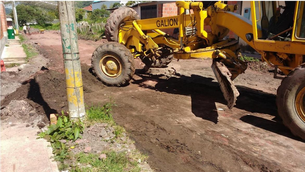
Fotografía 3 Conformación de calzada.
