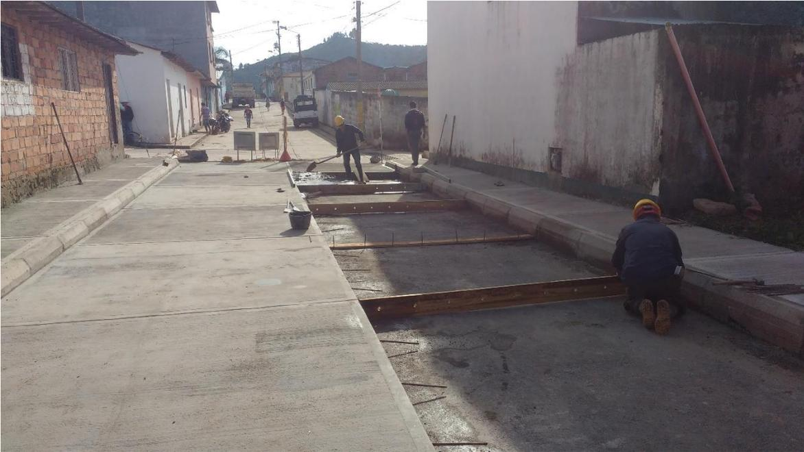
Fotografía 18 Colocación formaleta Para placa en concreto rígido.
