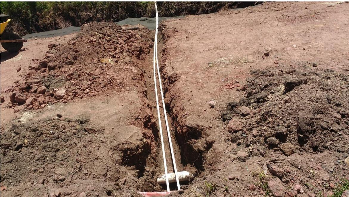
Fotografía 25 conexiones domiciliarias de agua potable.
