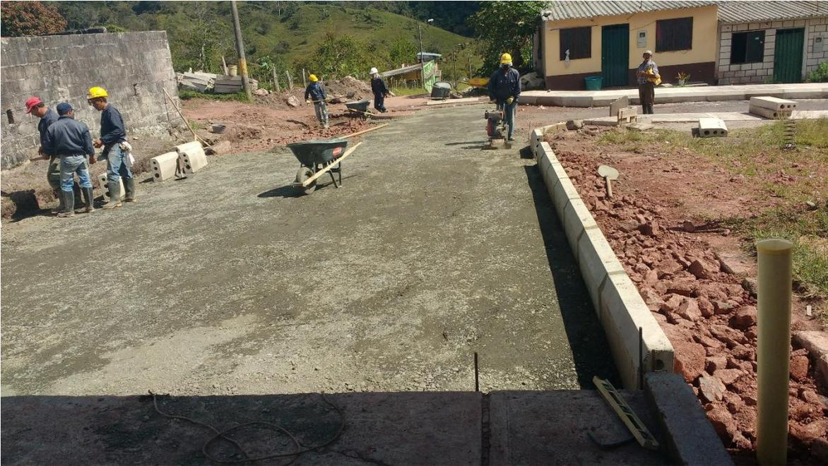
Fotografía 66 Extendido y compactación base granular.
