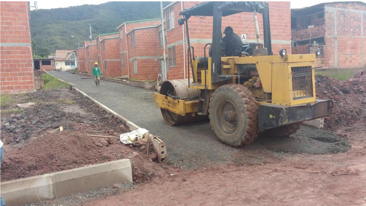
Fotografía 58 Extendido y compactación Base Granular.
