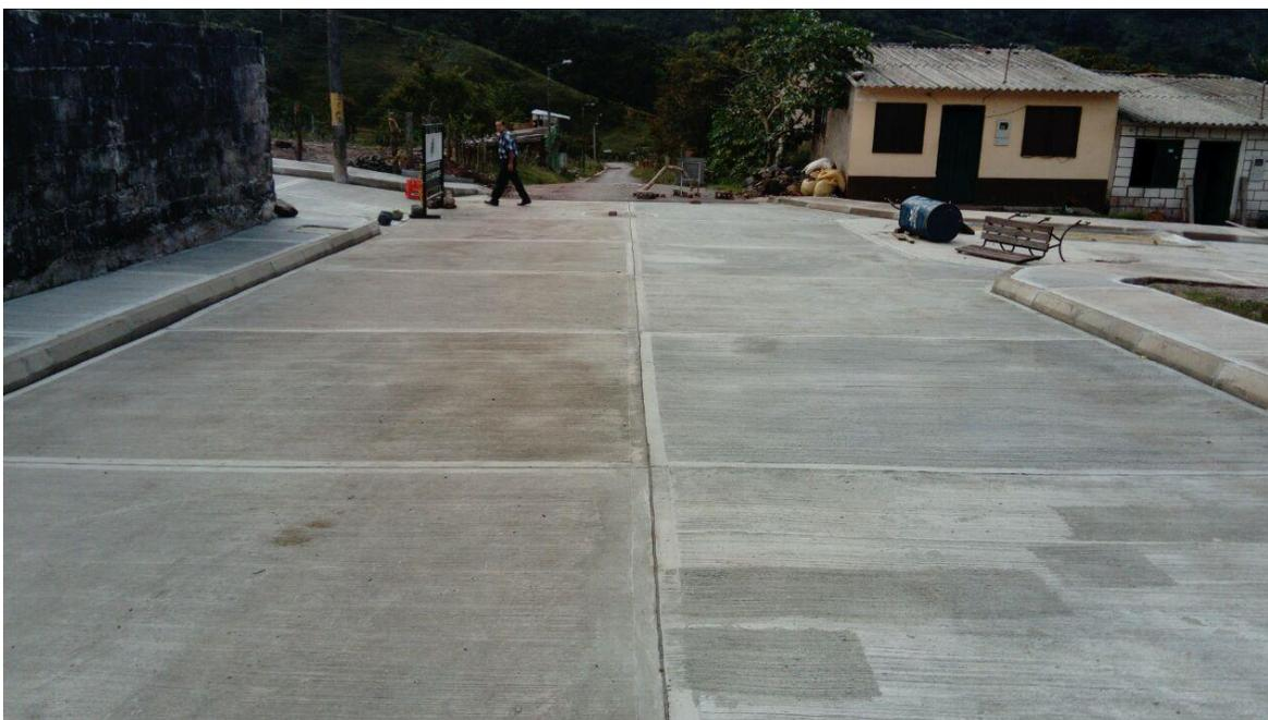
Fotografía 69 Construcción lozas de concreto tramo 5.
