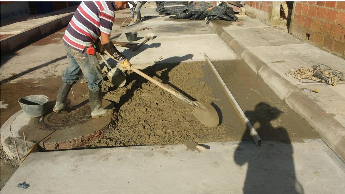
Fotografía 19 Vaciado concreto y nivelación.
