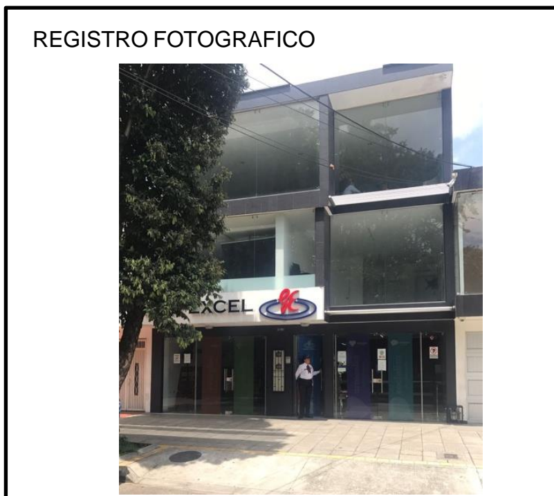
Figura 13. Registro fotográfico del establecimiento.
