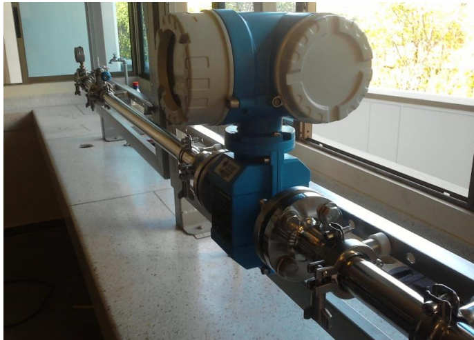
Figura 21: Puesta en marcha medidor Proline Promag 50 w [5]
