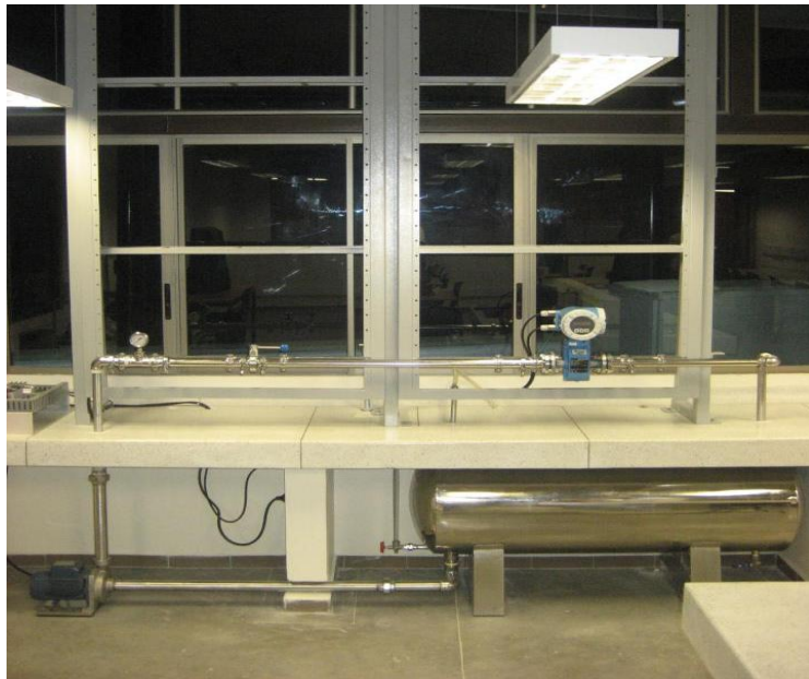
Figura 23: Puesta en marcha del medidor Proline 50 W [12]
