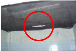
Foto 8. Malla de protección cuarto de almacenamiento empresa de aseo especial.
