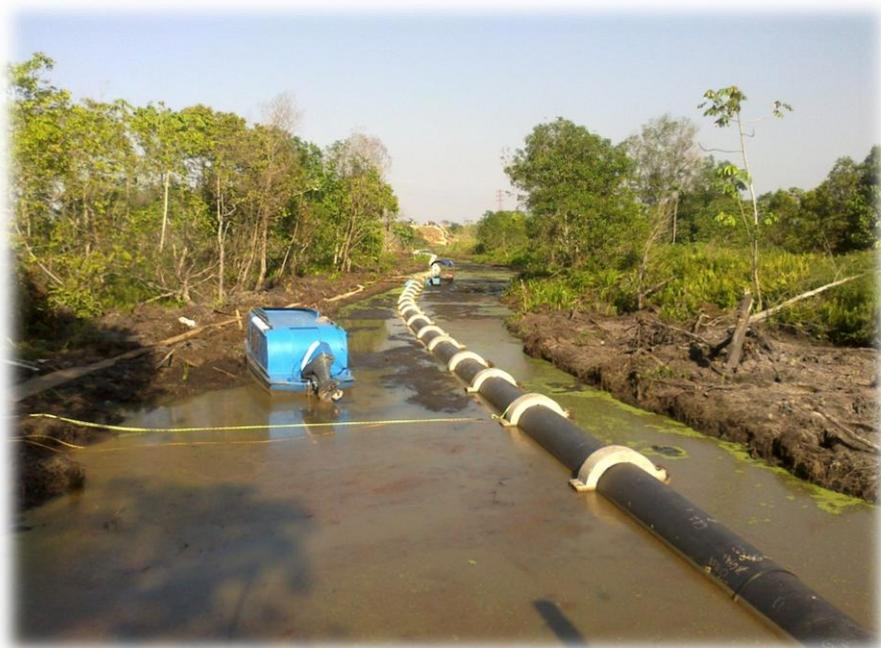
Figura 40 Instalación línea de agua San Silvestre sobre ciénaga Palotal.
