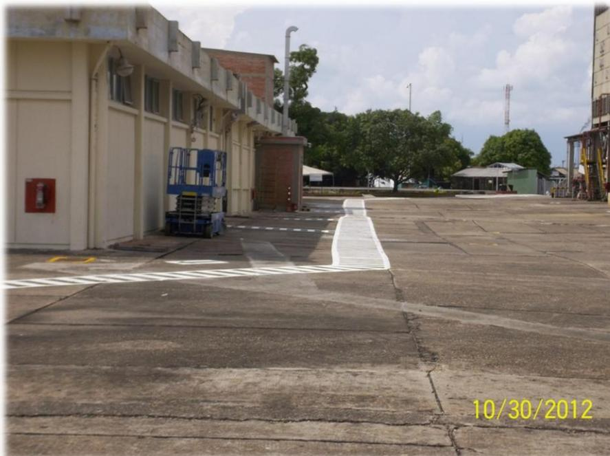
Figura 11 Detalle asentamientos visibles junto subestación eléctrica.
