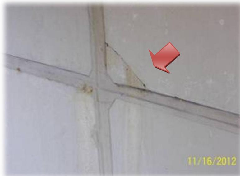
Figura 33 Fisura típica causada por inadecuada instalación de tornillos de fijación.
