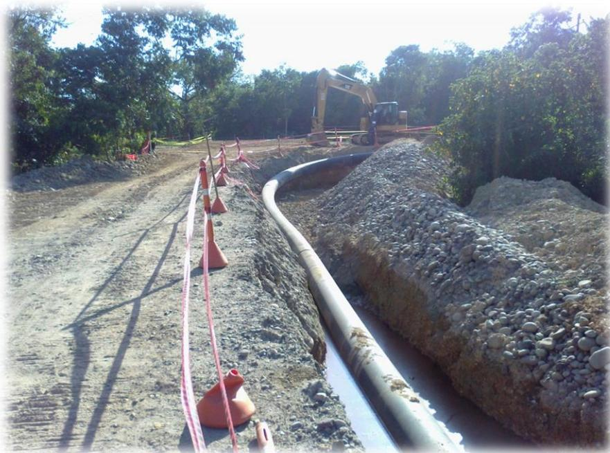
Figura 39 Instalación línea de agua San Silvestre.
