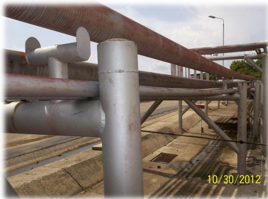
Figura 10 Detalle asentamientos visibles en soportes de tubería.
