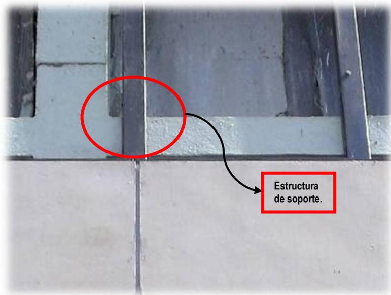
Figura 36 Detalle anclajes de los parales a la estructura de concreto existente por revisar.
