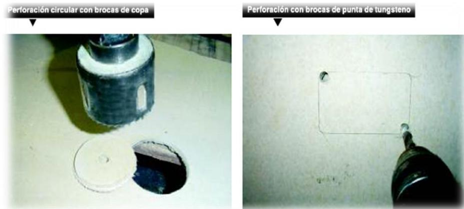
Figura 25 Manual de instalación. Perforación a placas de Súperboard. [5].
