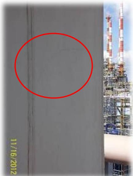
Figura 31 Fisura L/2 horizontal.
