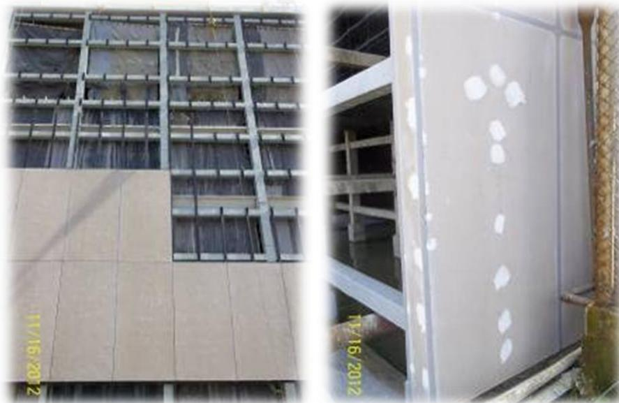
Figura 26 Instalación fachada flotante torres enfriadoras.
