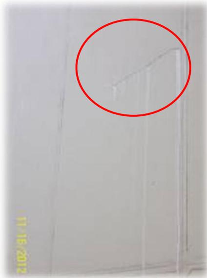
Figura 28 Fisura L/2 horizontal.
