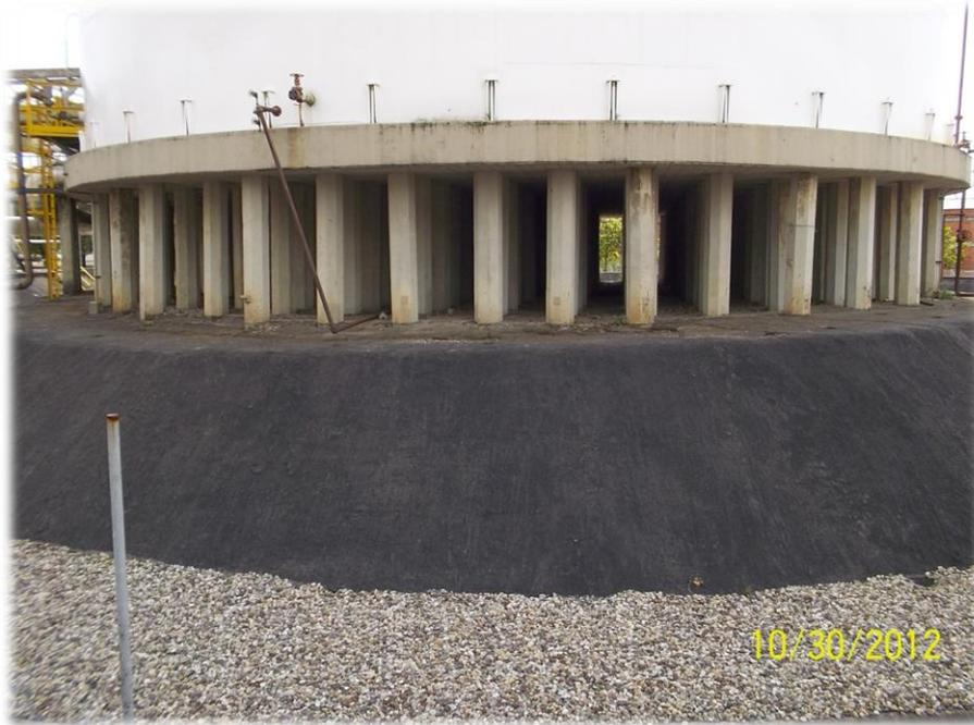
Figura 15 Detalle estructura soporte tanque criogénico k-4102.
