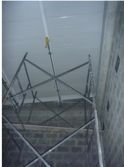
Imagen 19. Elementos de control de incendios
