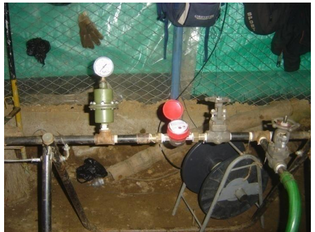
Figura 5. Montaje del sistema de medición del caudal de inyección y control de presiones de ensayo.
