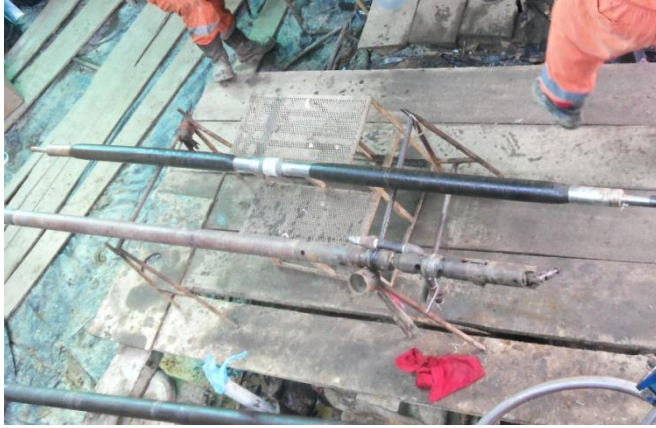
Figura 2. Prueba de inflado del obturador marca Geopro antes de ensayo.
