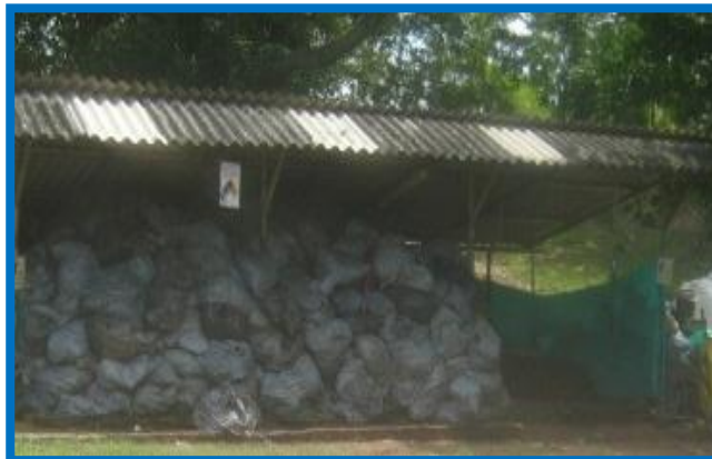
Foto 10. Almacenamiento de residuos sólidos impregnados de hidrocarburos
