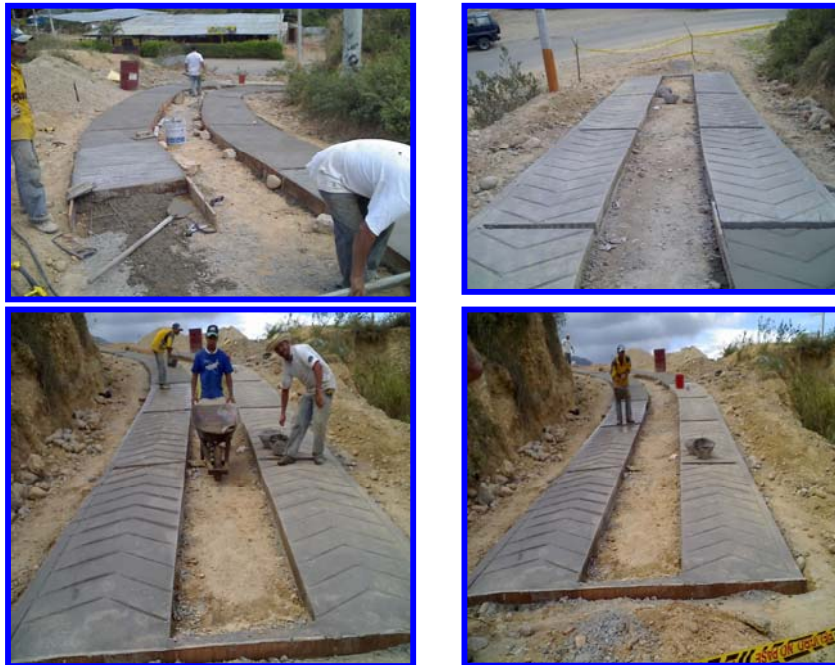
Figura 3. Construcción de huellas y enrocados. Vías de acceso vereda Lagunetas
