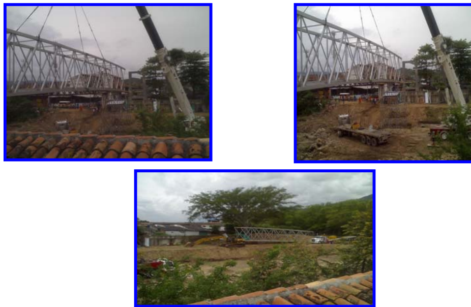
Figura 4. Puente peatonal del Malecón. Vía que comunica el casco antiguo con el Barrio Santa Cruz
