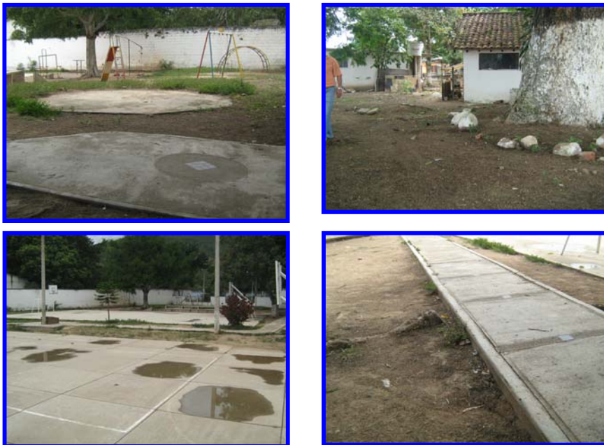
Figura 6. Construcción del Polideportivo. Barrio Santa Cruz
