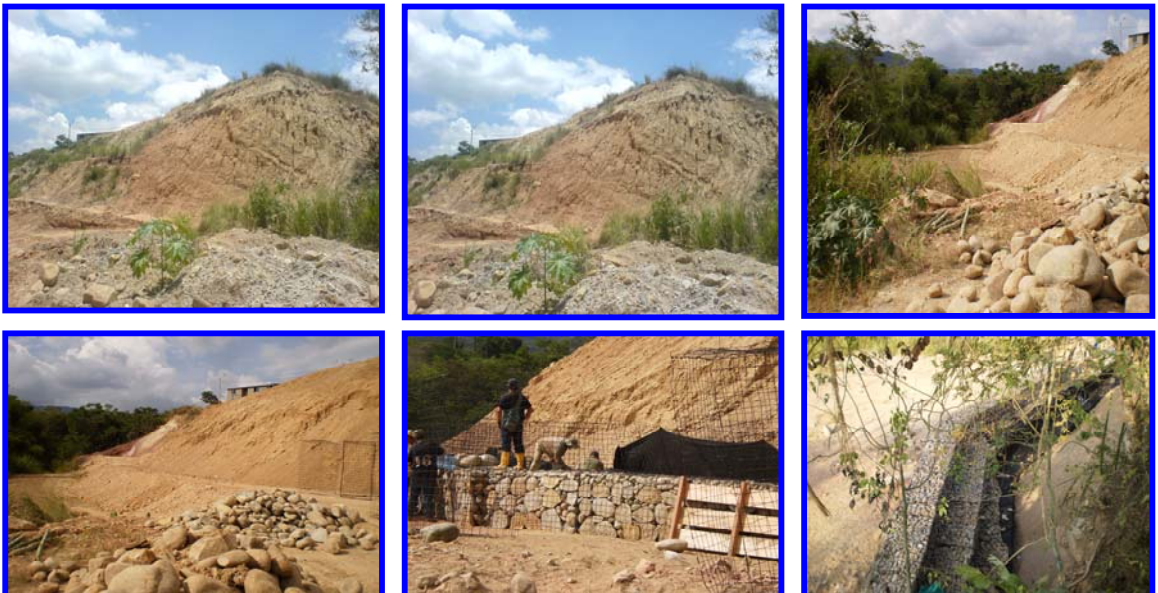
Figura 7. Muro en gaviones. Ciudadela Nuevo Girón
