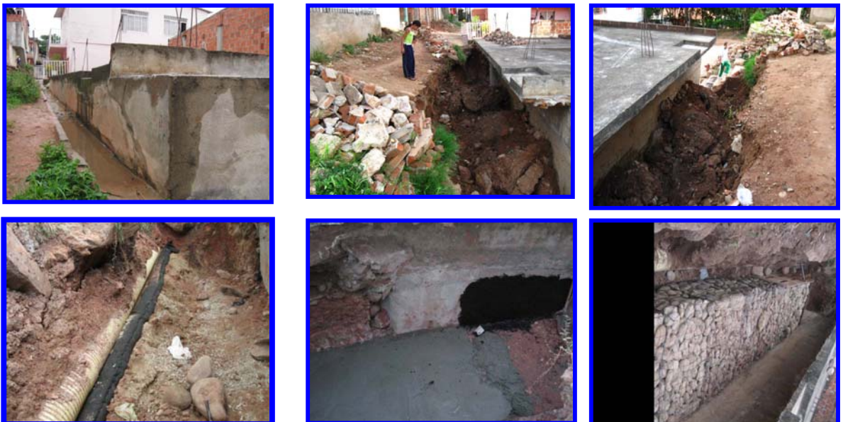
Figura 8. Gaviones y protección de talud con geotextil; filtros para aguas lluvias y humedades del terreno. Barrio Jardín de Arenales
