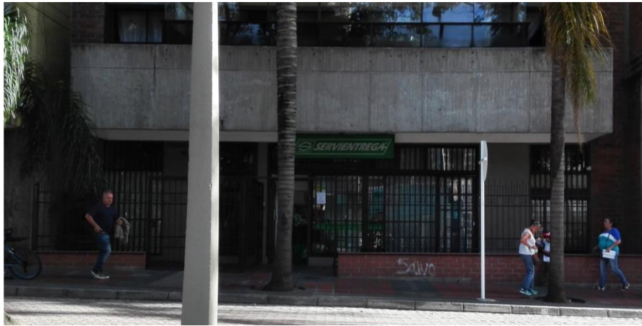
Figura 17. Primer piso del edificio Torre La Playa con cerramiento posterior
