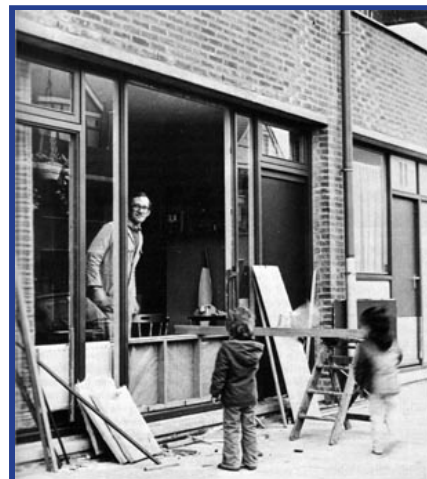
imagen 13. Fotografía construcción de vivienda Molenvliet, donde se aprecia los paneles de ventanería.
