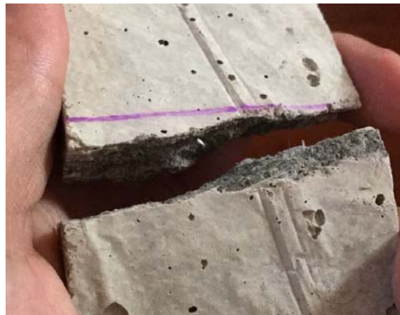
Imagen 30 - fisura expuesta a exceso de carga
