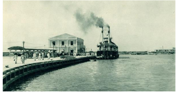
Imagen 14. Edificio de la Intendencia Fluvial. Actividad Portuaria en Barranquilla. Revista Latitud (1936)
