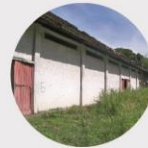
Infraestructura de Logística Industrial
