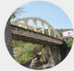
Puentes sobre el Río Gualí
