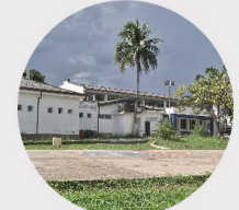
Equipamientos ordenadores y estructuradores
