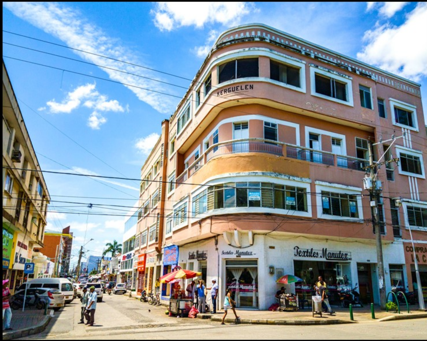
Edificio Kerguelen – Montería
