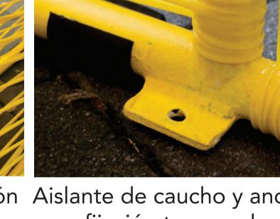
Tejido lateral con Cordón Aislante de caucho y anclaje para fijación temporal.
