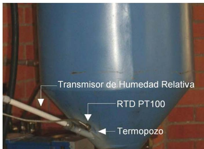
Figura 40: RTD PT100 y Transmisor de Humedad Instalados en la Tolva [17]
