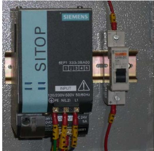
Figura 81: Interruptor de Protección Monopolar C32 H-DC [17]
