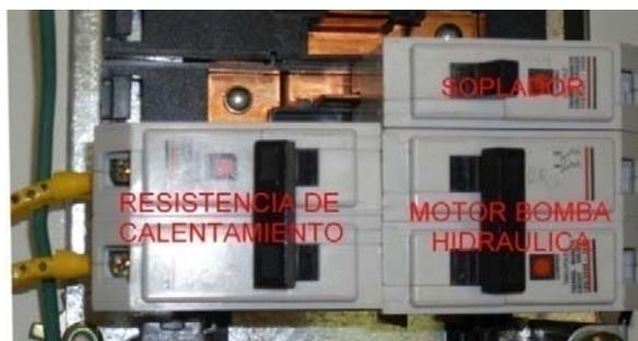
Figura 78: Tacos Termomagnéticos Instalados en el Tablero [17]
