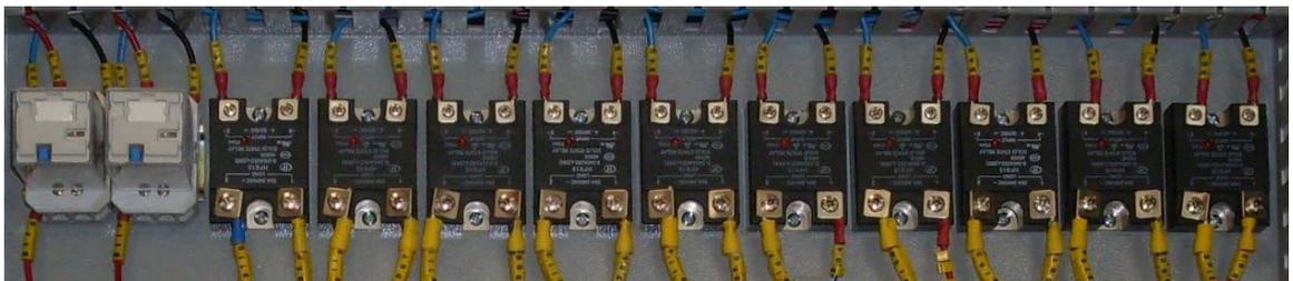
Figura 74: Instalación del Sistema de Acondicionamiento en el Gabinete [17]
