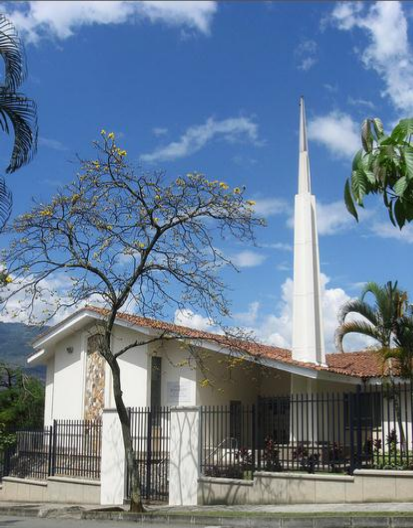
Imagen 83 . Iglesia-Patrimonio arquitectónico Barrio Prado Centro
