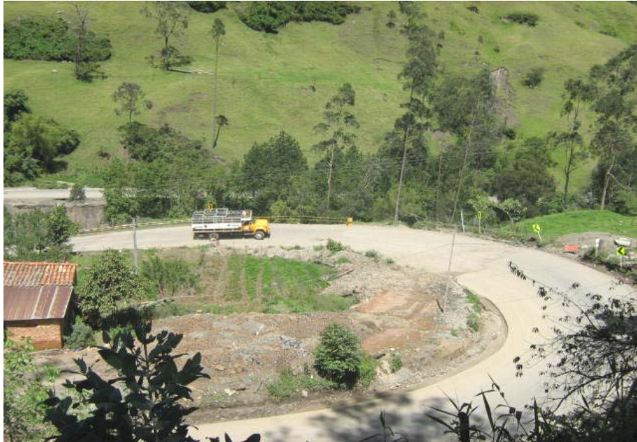
Panorámica de la curva ampliada en el PR73+000. Obsérvese que el sobrecancho logrado mejoro ostensiblemente la circulación de vehículos comerciales de radio de giro elevado.
