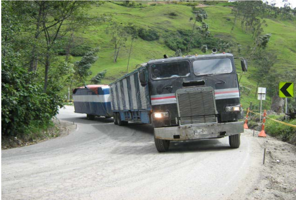
Curva de radio de curvatura máximo en el PR73+000 que ofrece restricción de circulación a vehículos comerciales de radio de giro elevado.
