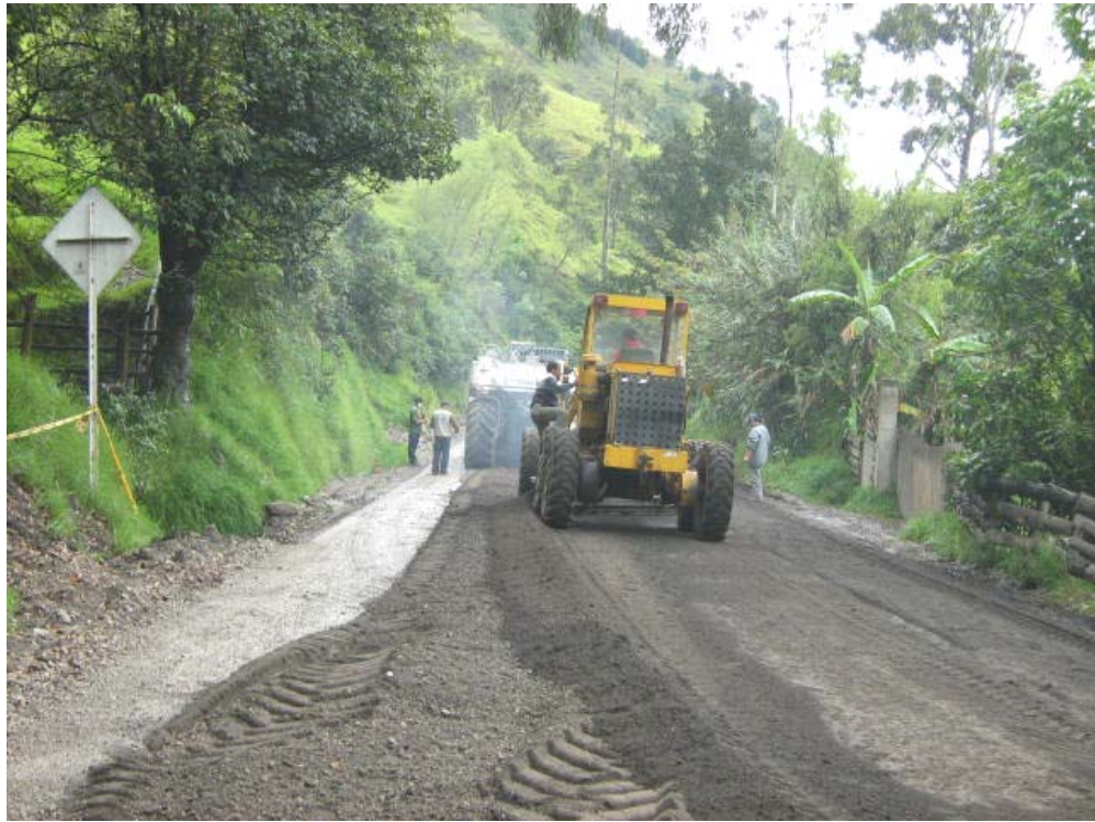
Reciclado del pavimento existente con adición de base granular en el PR73+250.
