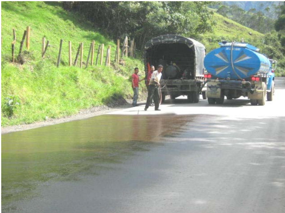
Riego de liga para la conformación de la segunda capa asfáltica con MDC-2 con gradación cerrada e=5 cms. Ubicación PR73+310.
