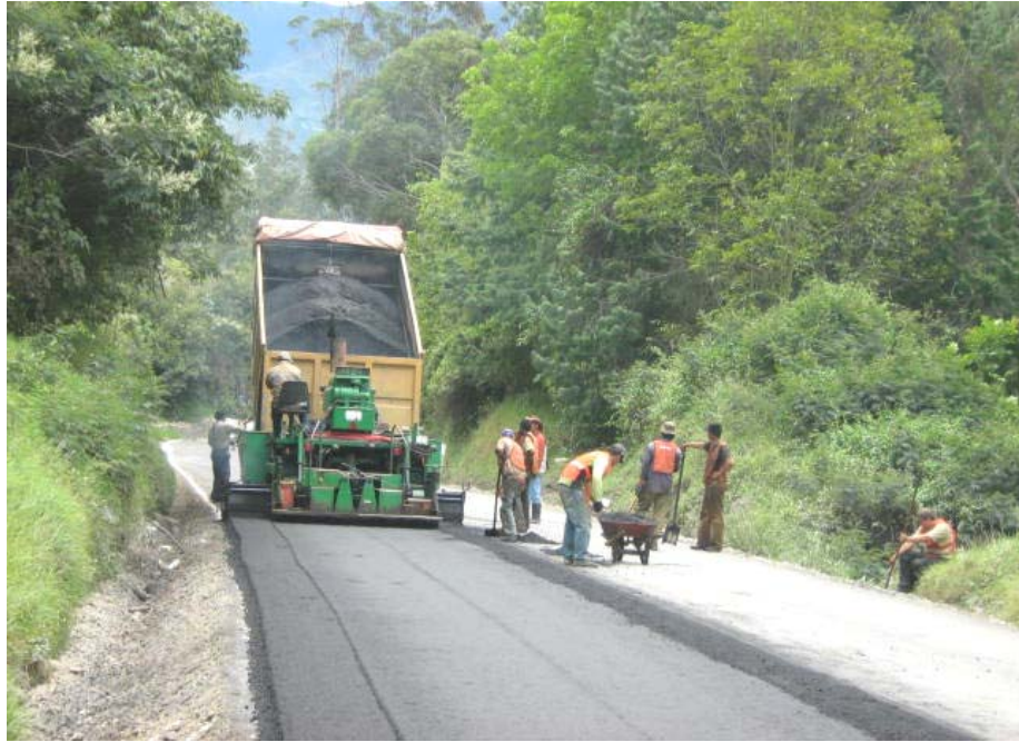
Suministro y colocación de MDC-2 para la conformación de la segunda capa asfáltica. Ubicación PR73+325.
