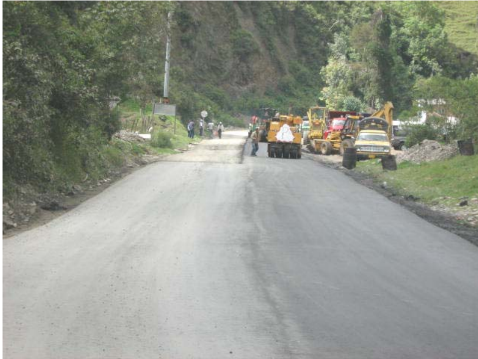
Compactación de la primera capa asfáltica e=7 cms en el PR74+100.
