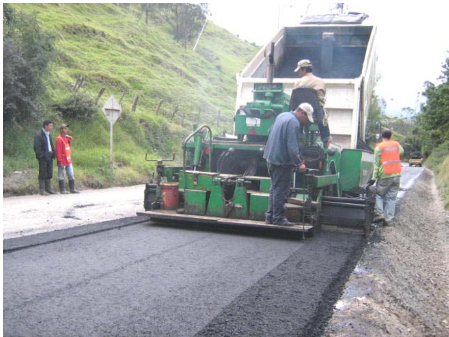
De la cota del pavimento existente, la nueva estructura del pavimento para el Tramo 1 quedo 38 cms por arriba. Obsérvese el espesor de las capas de reciclado y de Base Granular.
