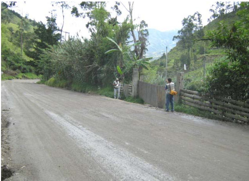
Control topográfico realizado por la Interventoría para el recibido de la capa de base granular en el tramo comprendido entre el PR73+250 y el PR74+504.
