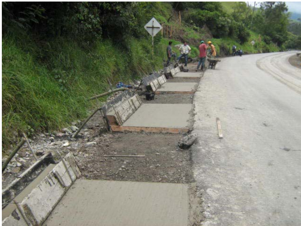
Construcción de cuneta en el talud de corte. Ubicación PR73+290.
