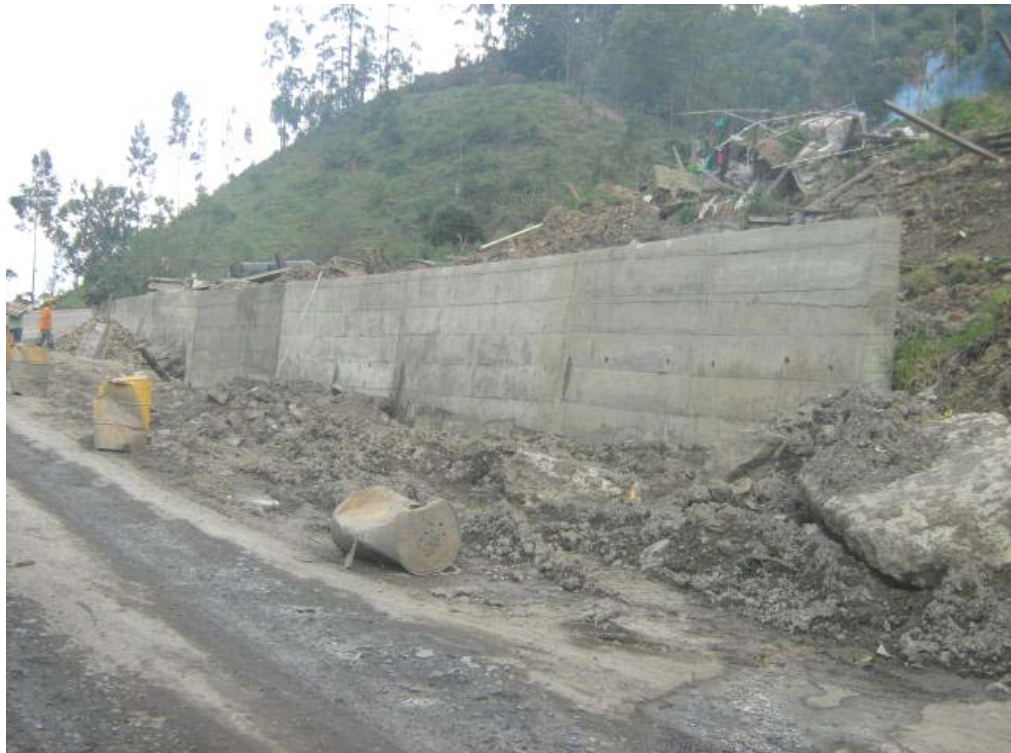
Vista general del muro construido de longitud total 34 mts.
