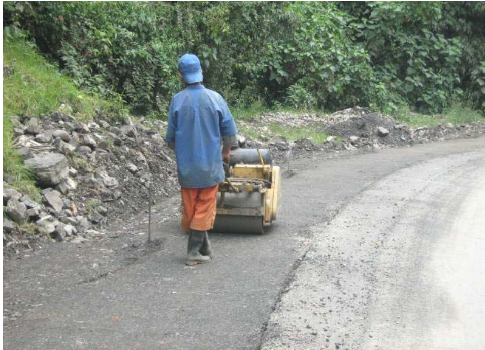
Compactación de material de cobertura para filtro el cual servirá de superficie de la cuneta. Ubicación PR73+340.
