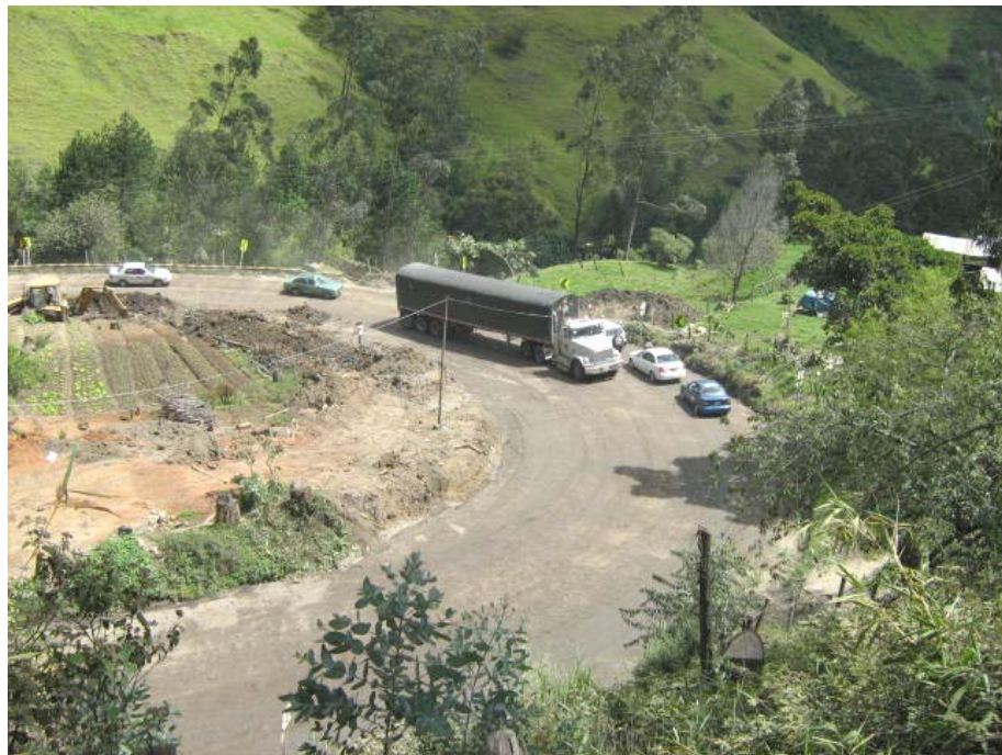
Condición mejorada para los vehículos comerciales de radio de giro elevado en la curva del PR73+000.
