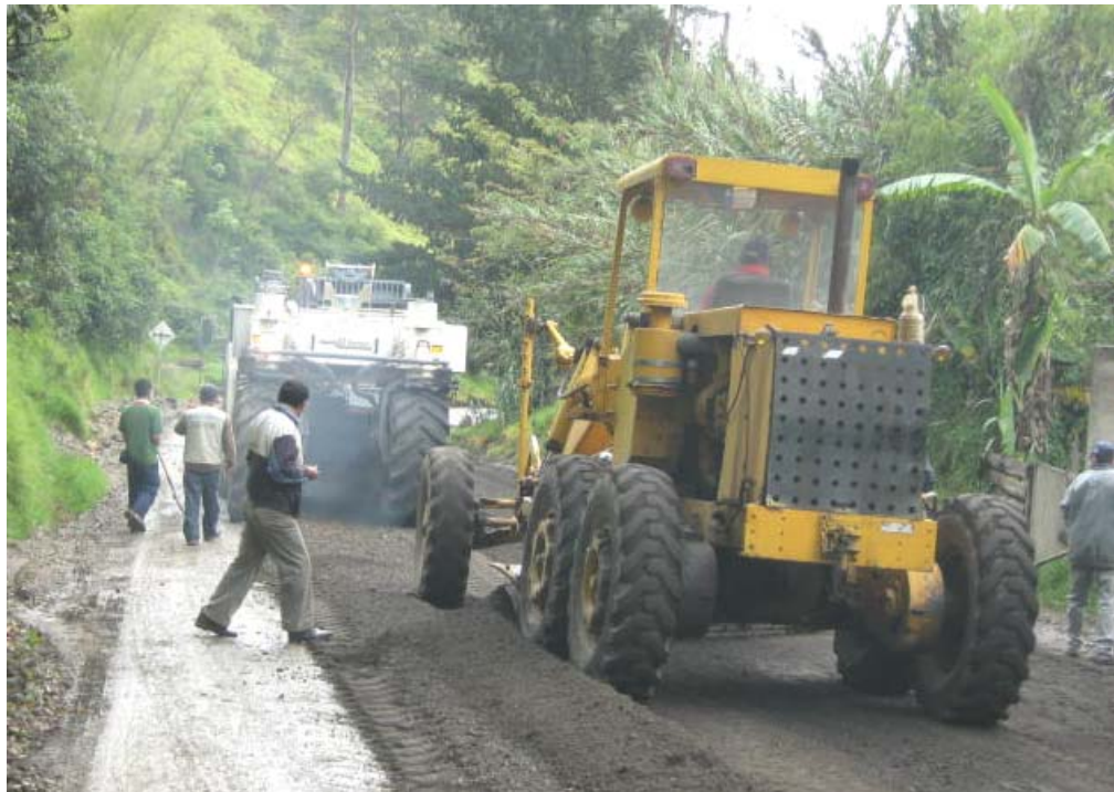
Extendido, homogenización y céreo de la capa de reciclado en el PR73+250.
