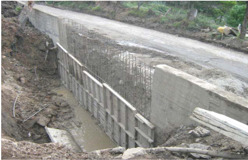
Colocación del refuerzo con acero grado 60 y disposición de la formaleta para fundir el segmento final del muro de longitud L=9 mts.
