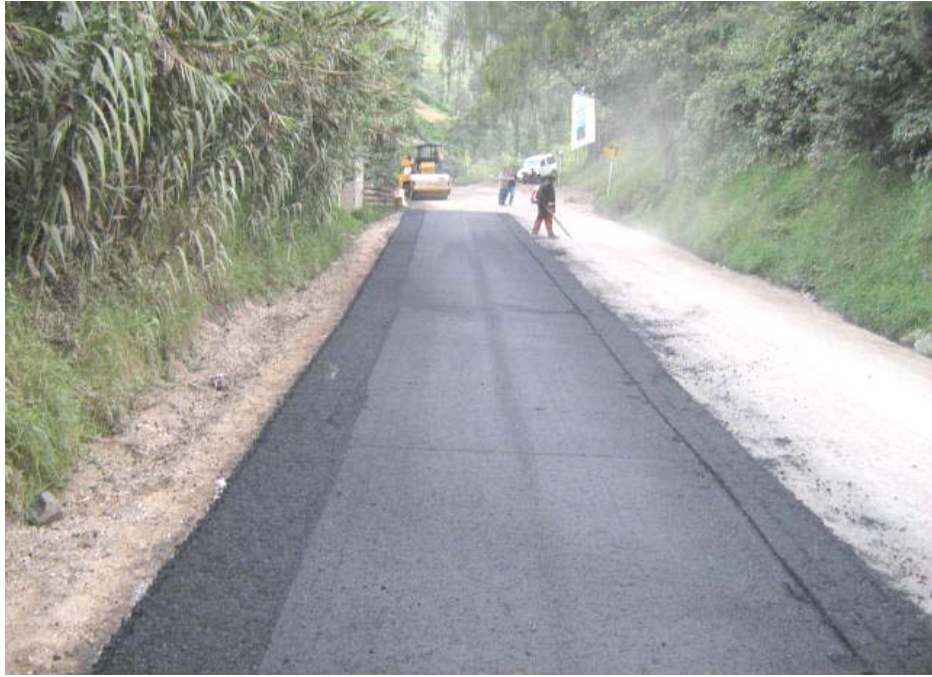
Vista general de la pavimentación en primera capa e=7 cms del carril derecho sentido Pamplona – Cúcuta en el PR73+000.
