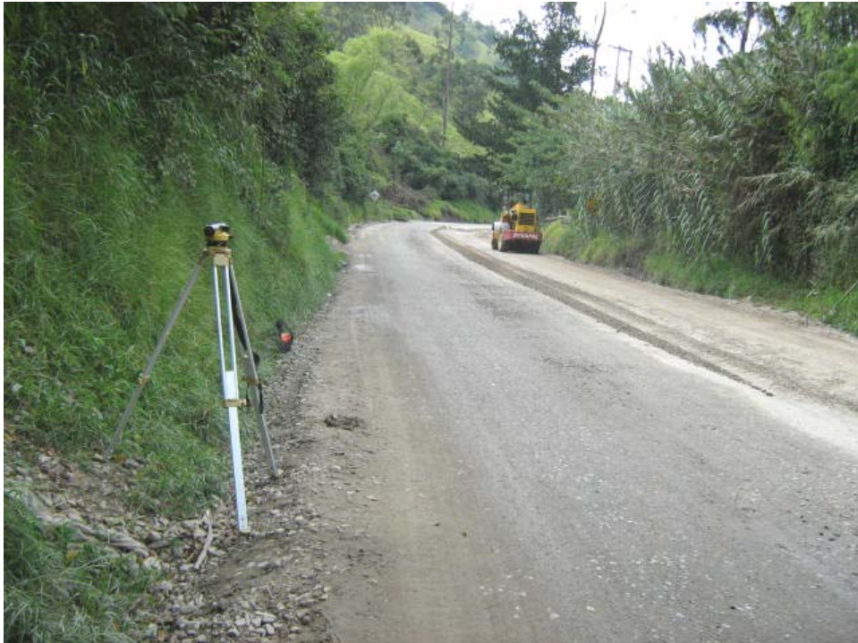
Céreo de la capa de base granular en el PR73+250.
