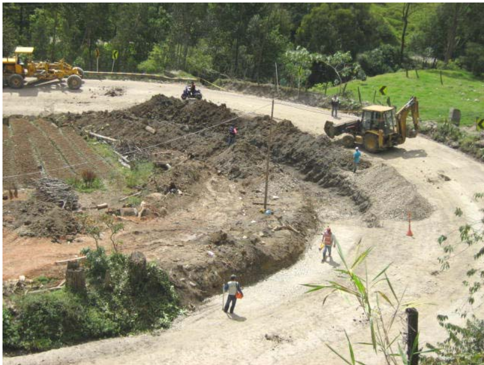
Ejecución de actividades para hacer el sobrancho interno de la curva en el PR73+000.
