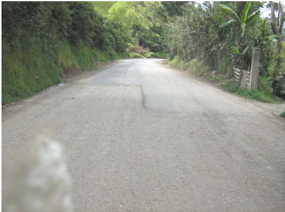
Vista general de la pavimentación en primera capa del Tramo 1. Ubicación PR73+250.
