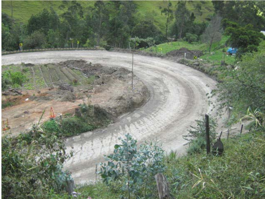
Vista general de la curva ampliada en el PR73+000.
