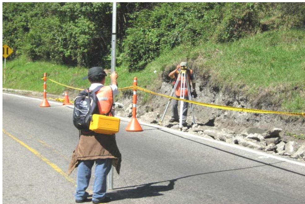
Comisión de topografía realizando verificación de cambios y referenciación del eje y límites transversales de la vía. Ubicación 73+380.
