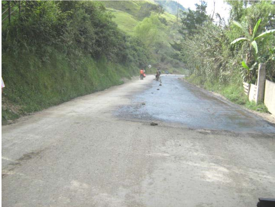
Imprimación de la base granular en el tramo comprendido entre el PR73+250 y el PR74+504.
