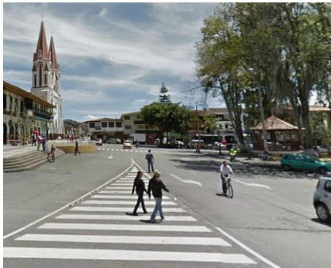
Figura 27. Fotografía de la vía que pasa por la plazoleta central del municipio de La Ceja, Antioquia, Colombia.
