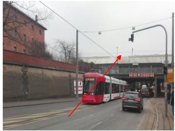
Figura 20. Fotografía de las líneas de alimentación aérea del tranvía pasando bajo un puente de Núremberg, Alemania.
