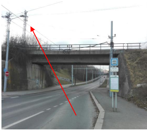
Figura 19. Fotografía de las líneas de alimentación aérea del trolebús pasando bajo un puente de Pilsen, República Checa.
