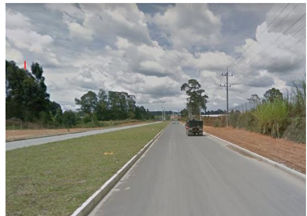
Figura 18. Fotografía de la vía El Tranvía del municipio de Rionegro, Antioquia, Colombia.
