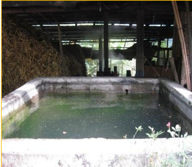
Ilustración 22. Tanques de agua que sirven para la refrigeración de los motores que mueven los trapiches. Fuente: Katerine Grajales, 2014.
