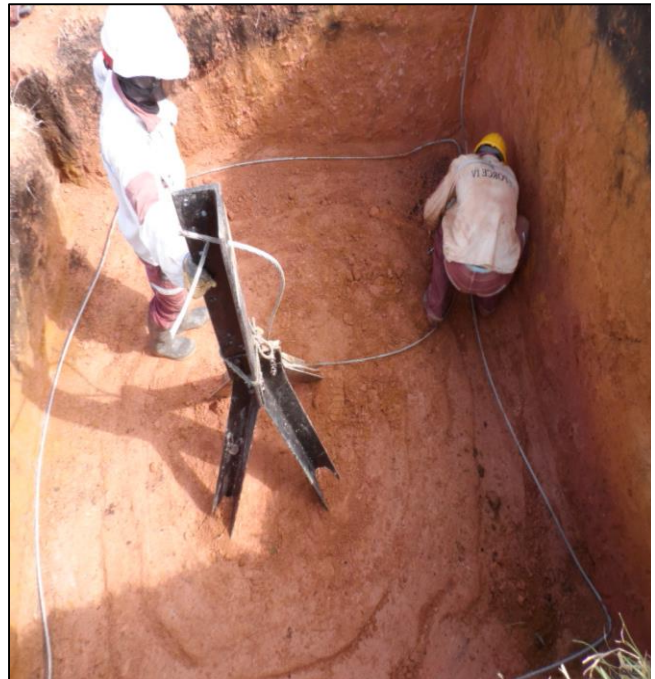
Figura 39. Instalación anillo de control de tensiones en cada pata
