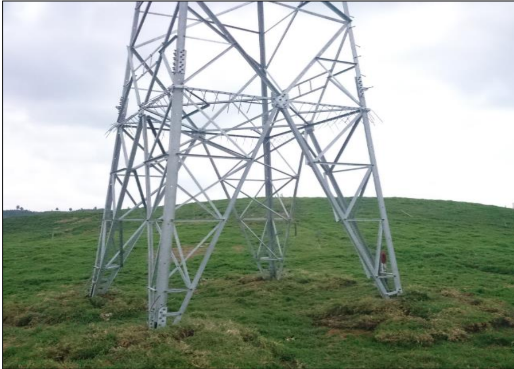
Figura 6. Patas torre autoportada configuración circuito sencillo
