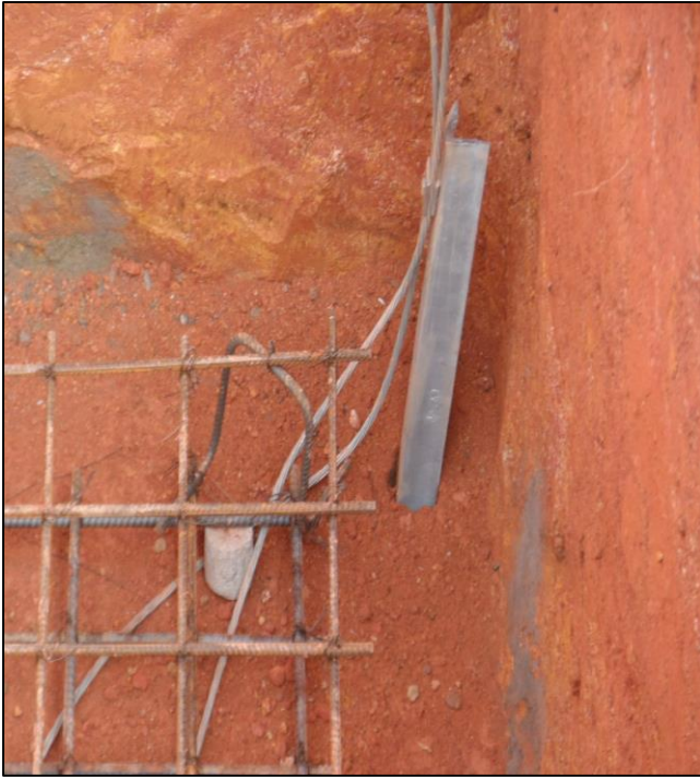
Figura 38. Instalación jabalina de puesta a tierra
