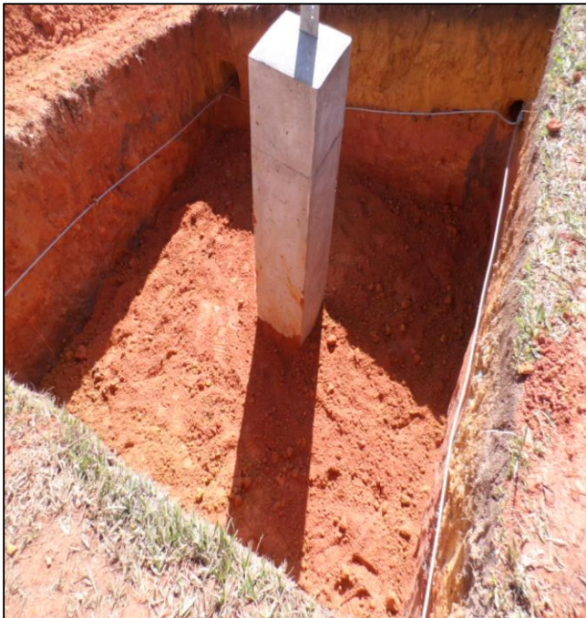
Figura 39. Instalación anillo de control de tensiones en cada pata
