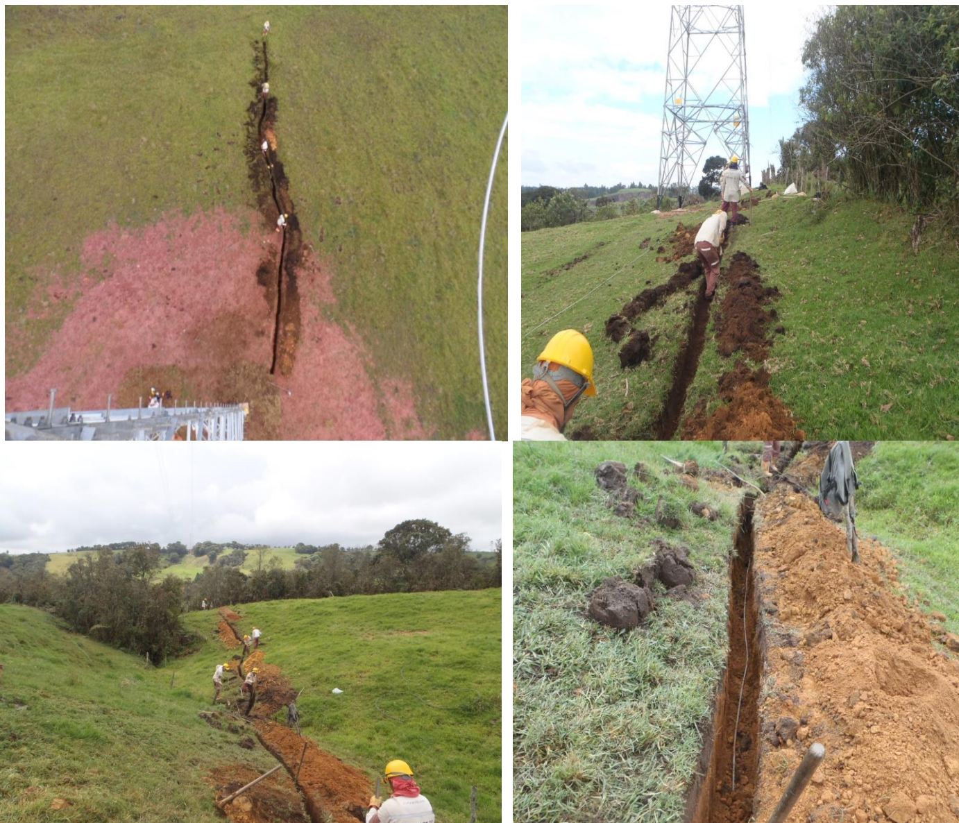
Figura 41. Instalación de contrapesos
