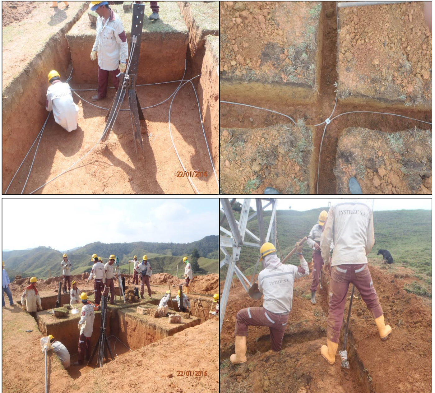
Figura 40. Instalación y compactación del anillo de control exterior
