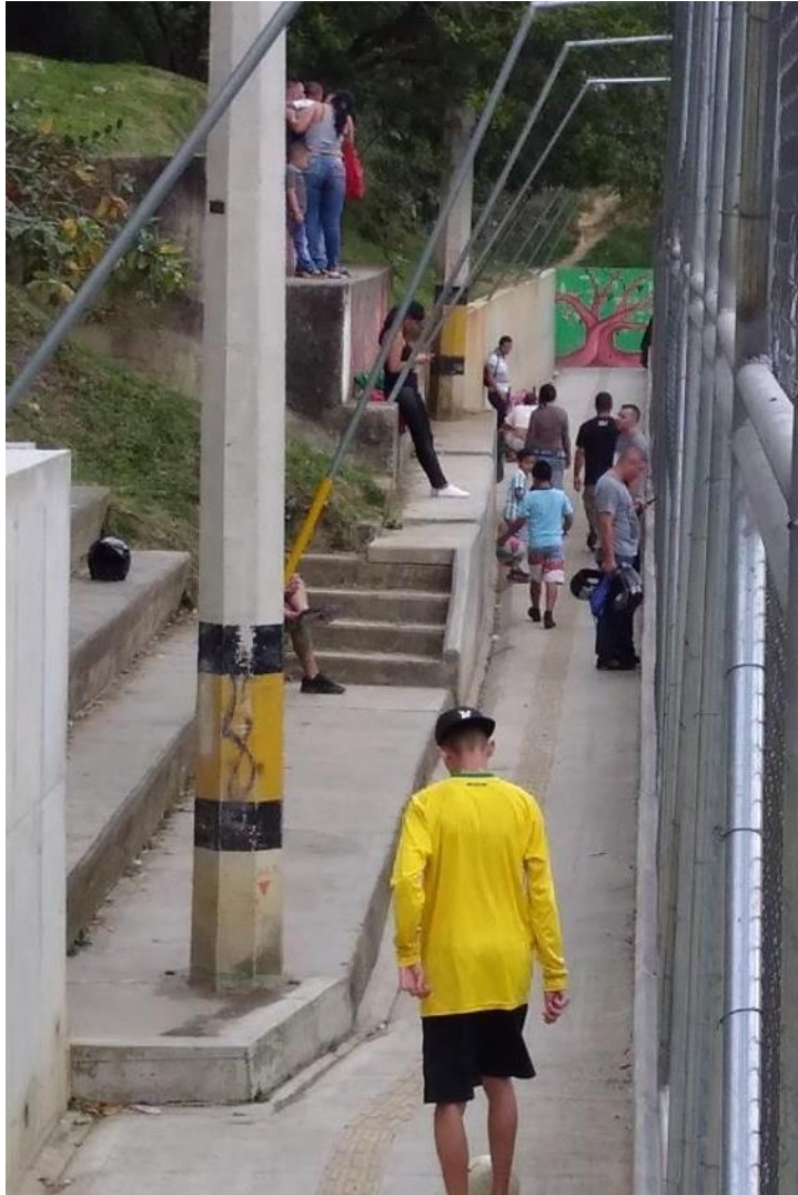
Graderías. Hechas en concreto, vaciadas in situ. Ubicadas a un lado de la cancha de fútbol. Lugar para sentarse y observar.
