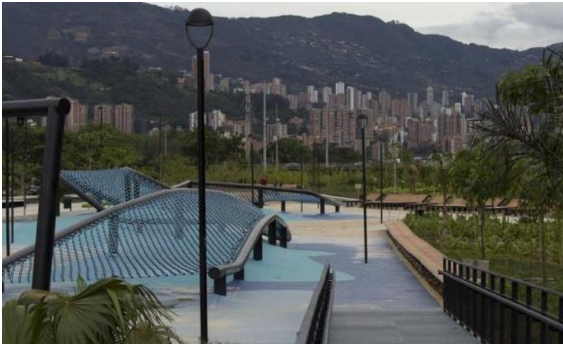
Malla orgánica. Estructura con malla metálica que forman un recorrido orgánico por Parques del Río.
