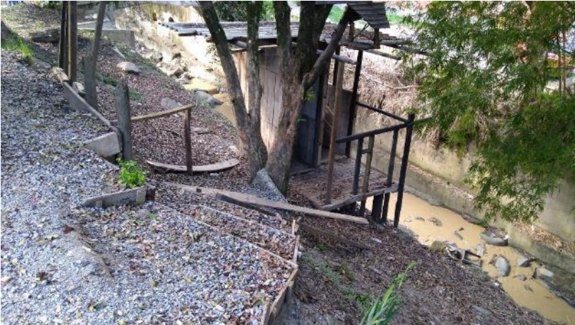
Piedras. Superficie en tierra reforzada con piedras pequeñas. Zona al lado de la tienda.
