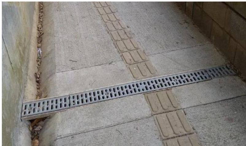
Desagüe rejilla. Esta hecho de acero inoxidable, ubicado el en costado lateral (anden) de la cancha de grama.
