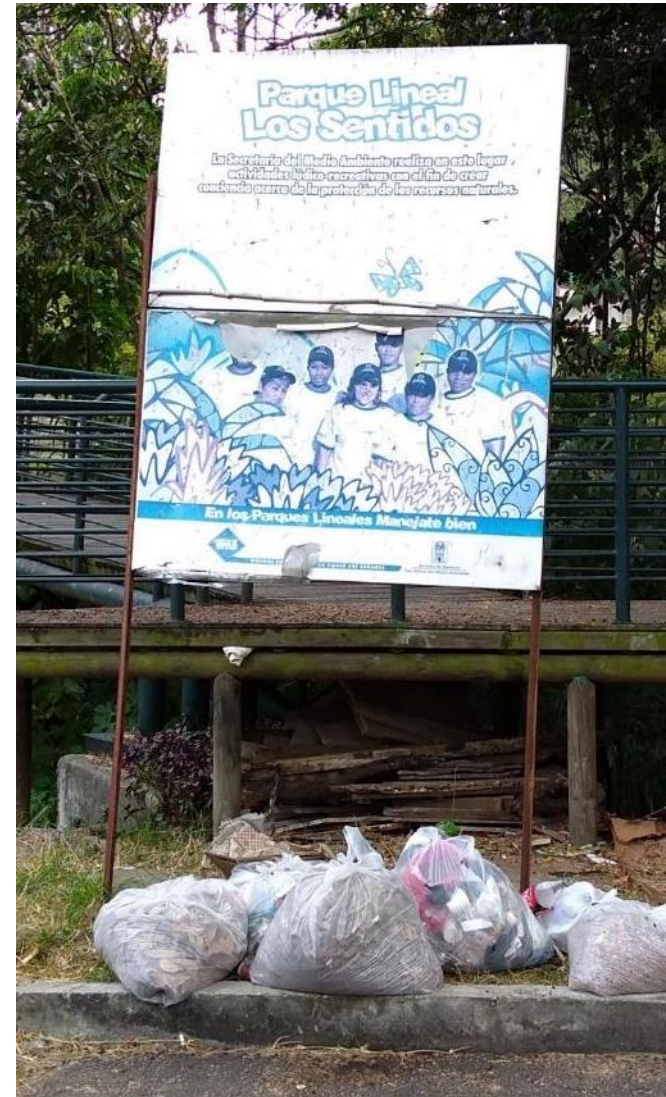
Aviso parque lineal. Aviso impreso en lona y puesto sobre lata metálica. Empotrado al suelo en varas.
