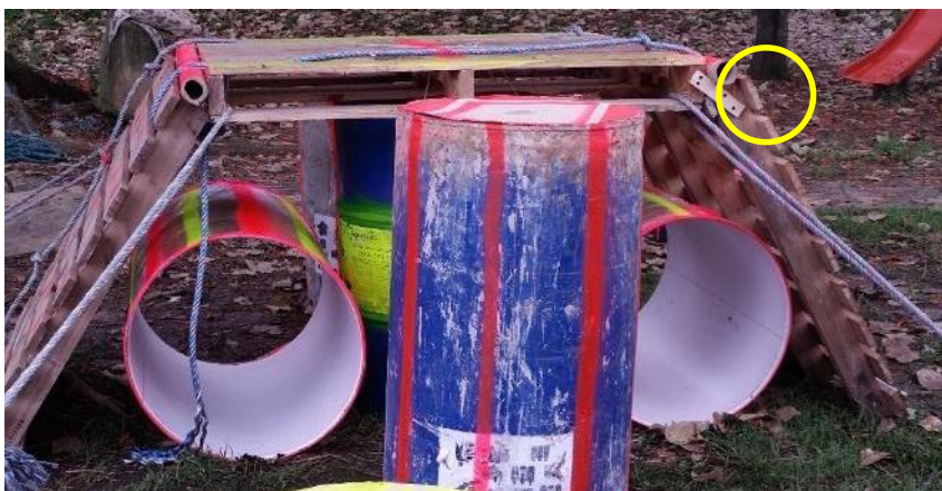
Sistemas de sujeción. Las estivas laterales estaban sujetadas a la superior con cabuya, tablas y tornillos de ensamble. Los tubos de cartón se utilizaron para llenar el espacio que quedaba entre las estivas.
