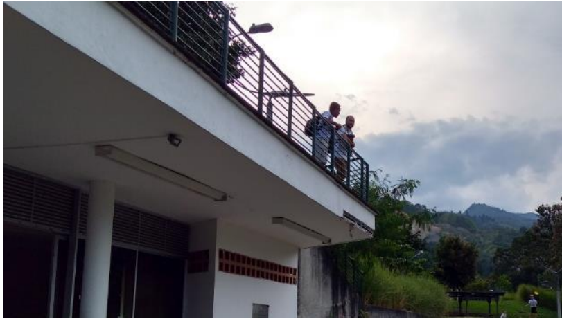
Baranda mirador. Parapeto en voladizo de mirador. Funciona como barrera de protección. Hierro y pintura.
