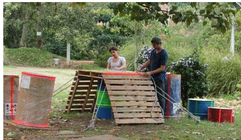
Amarre de cuerdas. Las cuerdas para escalar se amarraron del otro extremo de la plataforma para escalar y así generar más superficie de agarre y estabilidad en el sistema.
