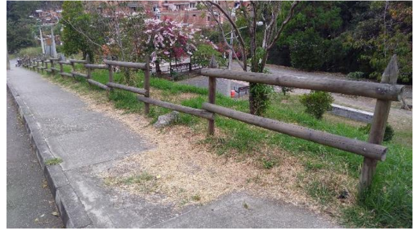
Baranda madera. Baranda de madera, listones redondos de pino inmunizado. Separación entre acera y pendiente. Ubicado en la loma hacia el taque de agua.
