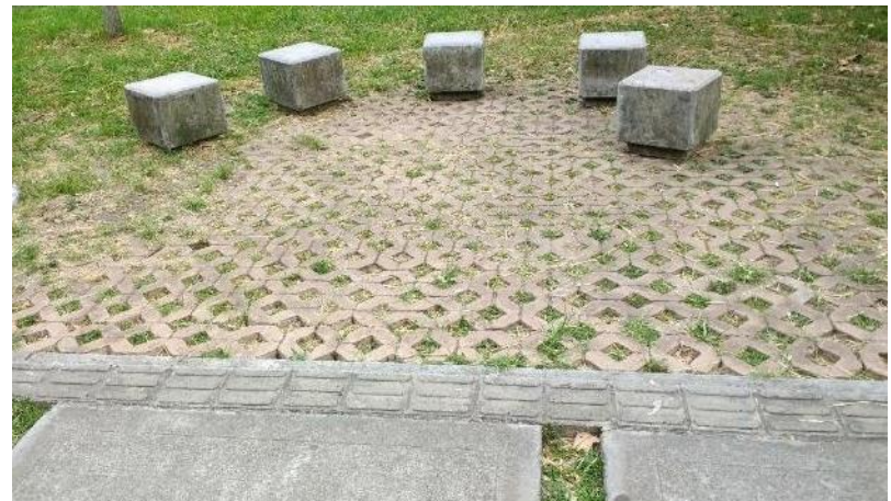
Piso mixto. Adoquines con agujero central permite el paso de la grama y crear un piso blando y duro. Lugar de permanencia. Franja táctil y baldosas grandes.
