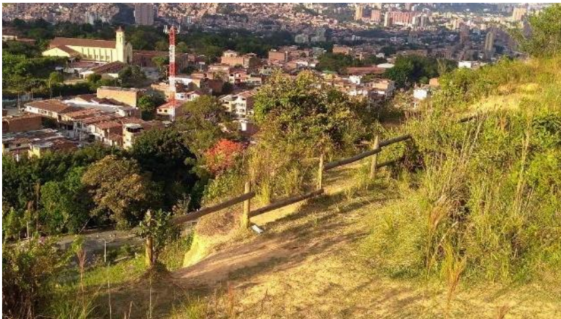
Baranda madera. Baranda de madera, listones redondos de pino inmunizado. Barrera de protección hacia la pendiente. Ubicado en la cima del mirador.
