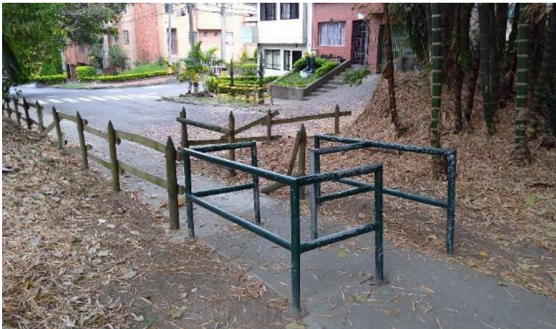
Barandas. Baranda de madera, listones redondos de pino inmunizado y de hierro delimitando la circulación. Ubicado en la salida del parque.
