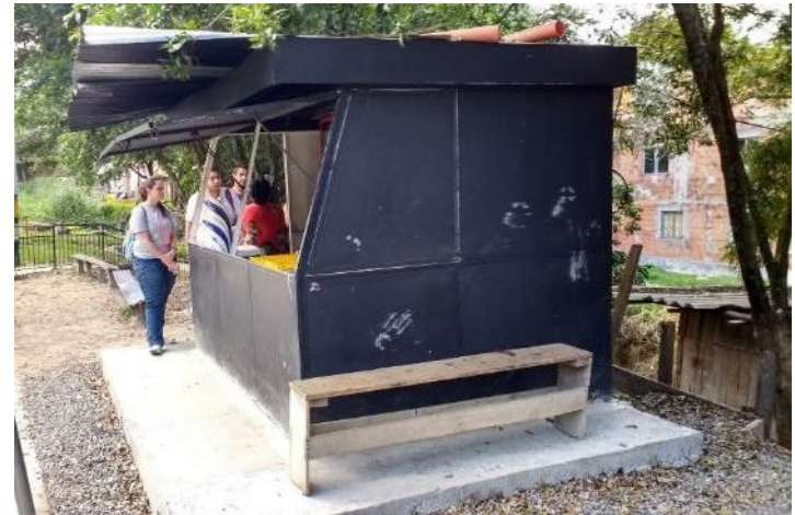
Banca y tienda. Tienda al lado de la cancha y banca lateral. Tienda en latón y banca de madera común.
