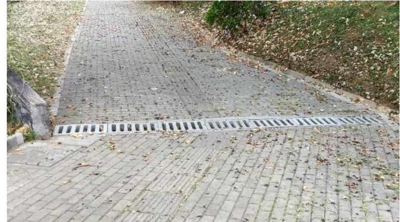
Desagüe piso. Piezas en concreto con estructura de varilla de hierro, se encuentra en una pequeña pendiente que permite el drenaje de agua.
