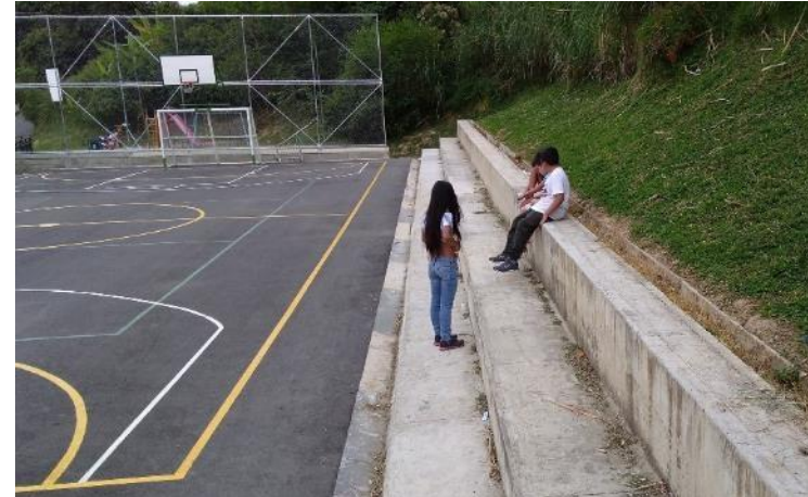
Graderías. Graderías en el lateral, ubicadas en la cancha polideportiva. Hechas en concreto, vaciadas in situ.
