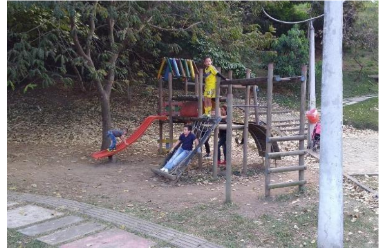
Parque infantil. Lisadero, túnel, pasamanos, columpios. Listones cilíndricos de madera inmunizada, fibra de vidrio, cadenas de hierro, soga. Ubicado en el parque lineal de los sentidos.
