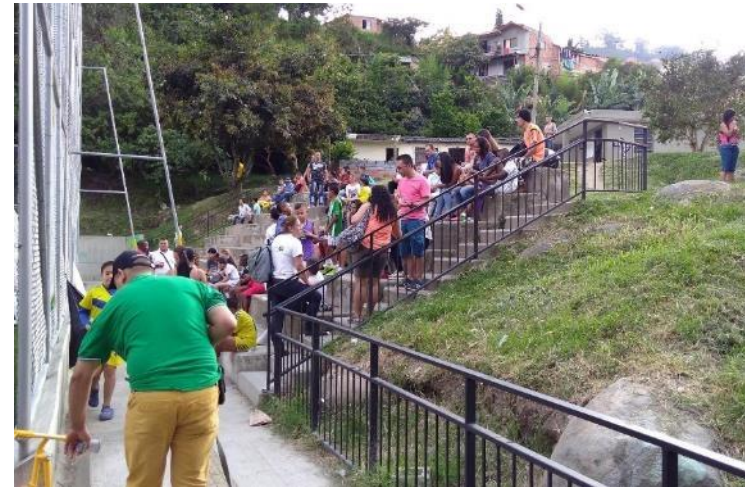
Graderías. Hechas en concreto, vaciadas in situ. Ubicadas frente a la cancha de fútbol.
