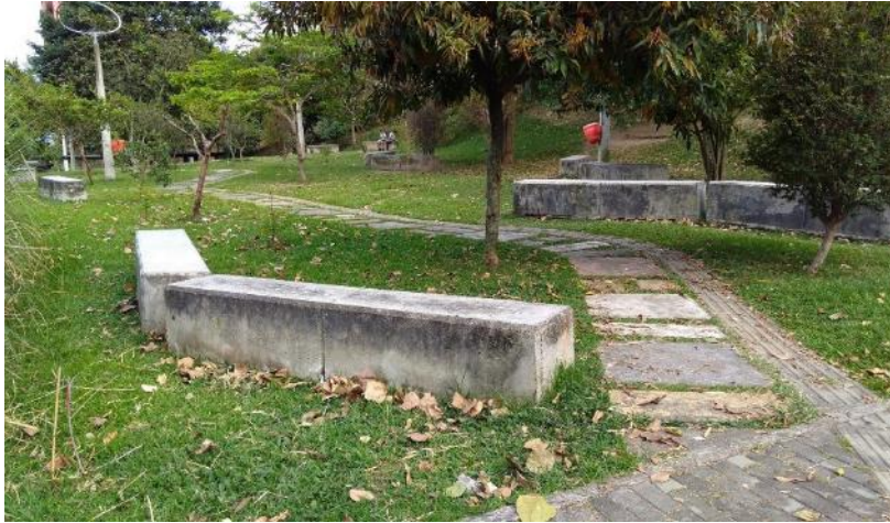
Banca de concreto. Banca monolítica de concreto vaciada in situ. Ubicadas a lo largo de la zona verde del parque de los sentidos.
