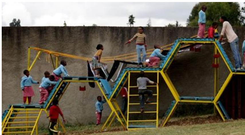
Hexágonos. Hecho en concreto con estructura de varilla de hierro. Césped y residuos naturales tapan gran parte del.
