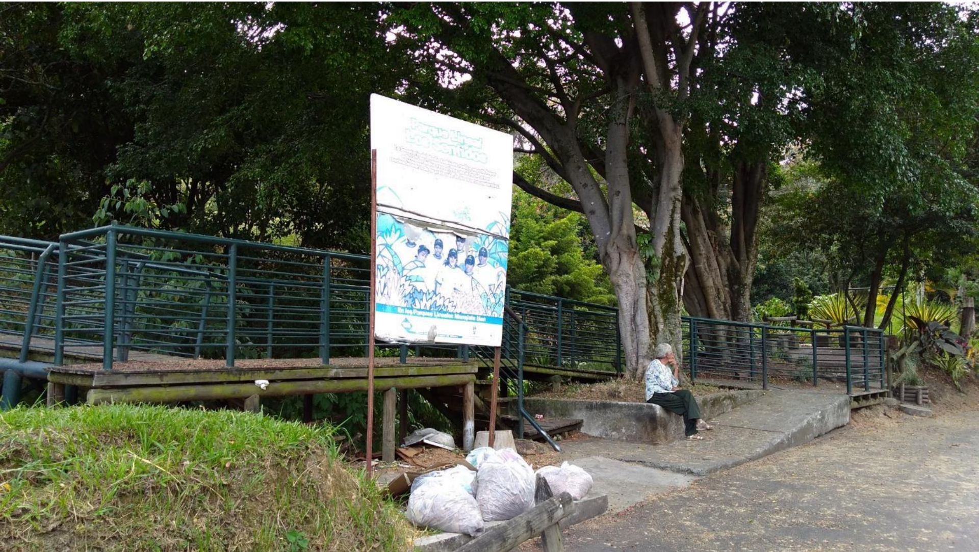
Barandas delimitadoras de circulación . Parapeto que delimita el puente de entrada al parque. Hierro y pintura anticorrosiva. Entrada nororiental.
