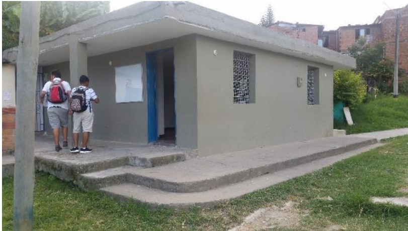
Salón de inscripciones. Salón administrativo para pagar matrículas. Ubicado arriba de la cancha.
