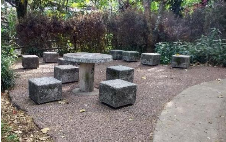
Cambio de piso. Combinación de acera en concreto (circulación) y piso blando de caucho triturado (permanencia). Bioparque Ana Díaz.
