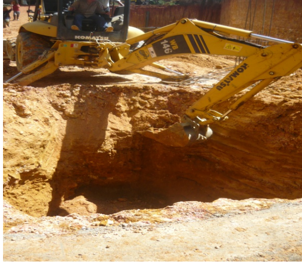
Cimentación, Excavación a máquina 18 .
