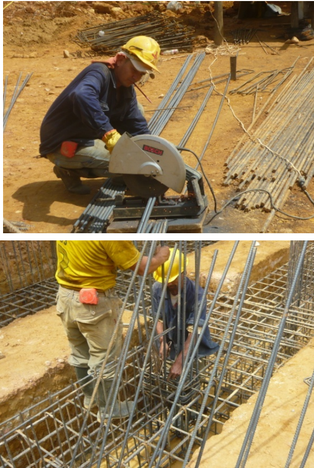
Figurada e instalada de Acero en cimientos 42
