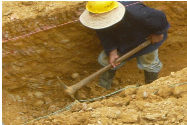
Excavación a mano cimientos 21
