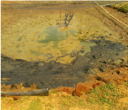
Figura 5. Lodos en el fondo de los estanques.
