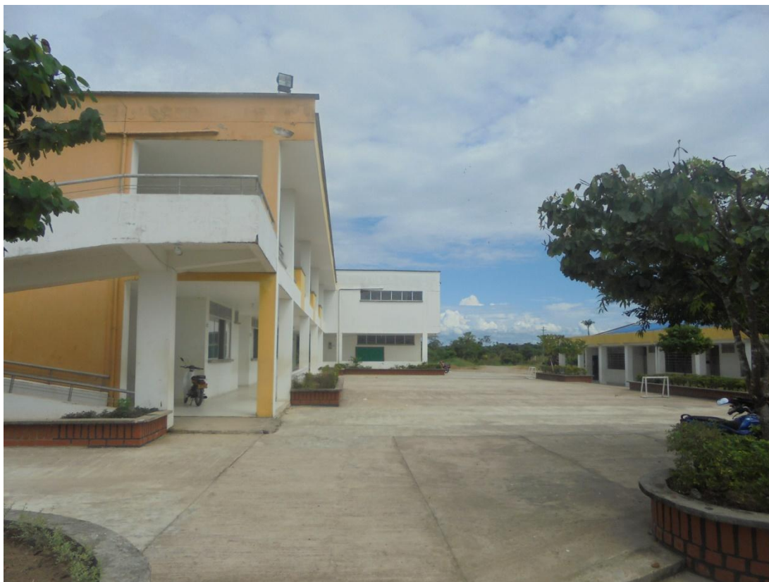
Figura 4. Instalaciones de la Institución Educativa. Autoría propia.
