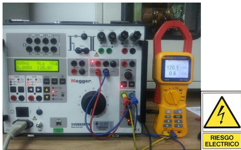
Figura 5. Comparación de tensiones entre voltímetro externo y SVERKER
