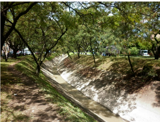
Fotografía // Quebrada canalizada
