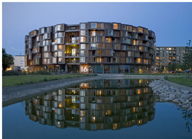
Edificio de vivienda colectiva // fachada exterior
