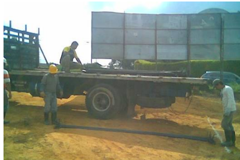
Imagen # 10: Llegada del pedido de hierro
