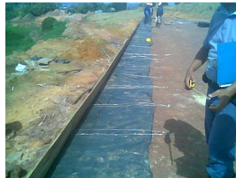
Imagen # 14: Anclaje de la formaleta
