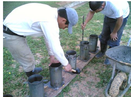
Imagen # 5: Compactación y vibrado
