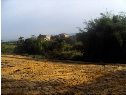
Imagen # 5: Localización y replanteo
