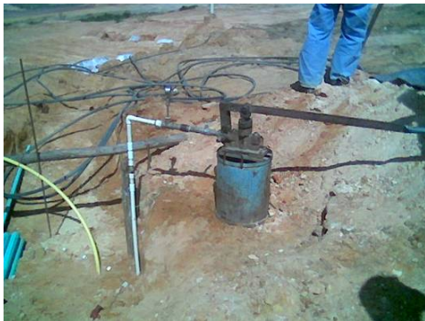
3. Imagen # 8: Toma de muestras . DE ING Imagen # 9: Presión de 150 PSI .OS CONTRATISTAS A LA OBRA.
