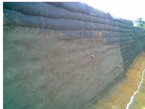
Imagen # 16: colocación de malla y chafarreo
