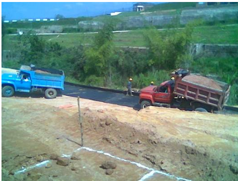
Imagen # 7: Extendida del geotextil
