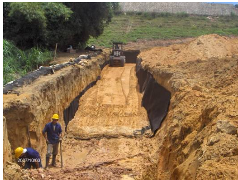
Imagen # 8: Relleno de capas
