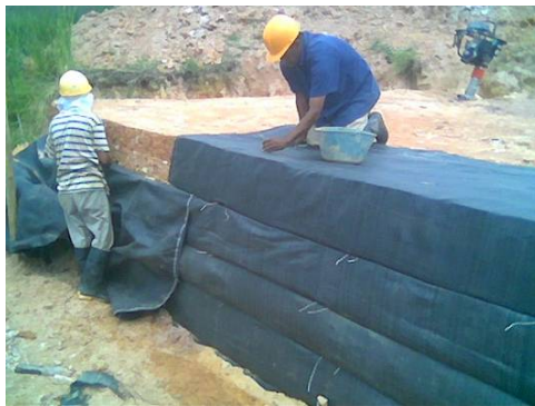
Imagen # 13: Estiramiento del geotextil
