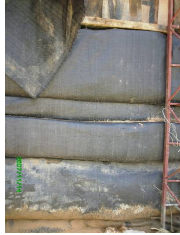
Imagen # 3: Diferencia en el espesor entre capas
