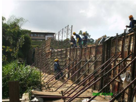
Imagen # 1: Montaje de formaleta
