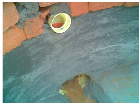
Imagen # 6: Cañuela y ventilación
