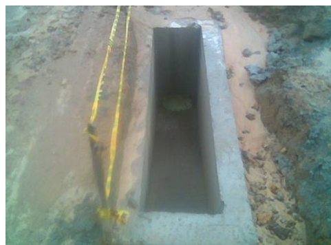
Imagen # 7: Construcción de sumideros
