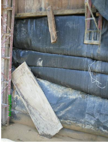
Imagen # 2: No horizontalidad de las capas de alineamiento
