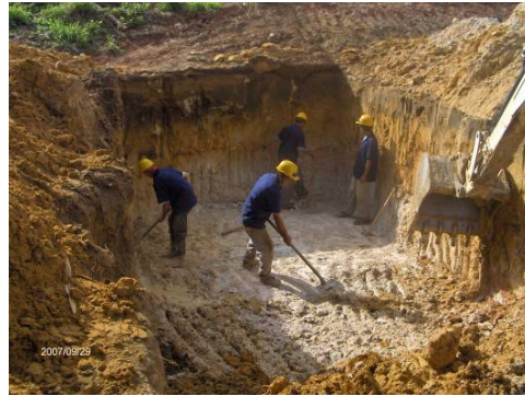
Imagen # 6: Excavación y retiro de material
