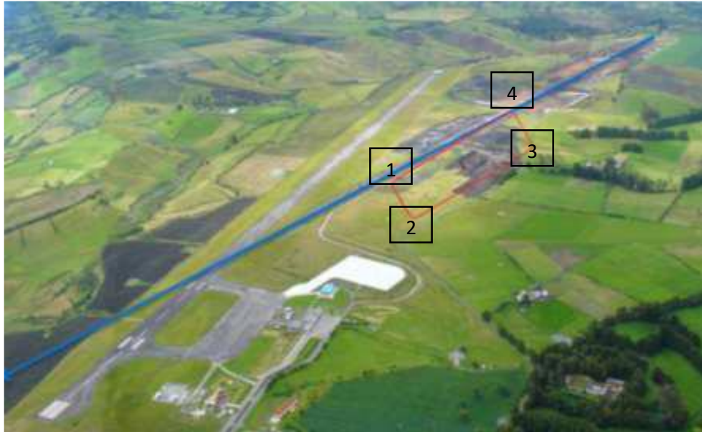
Figura 2. Vista aérea del lote ubicación de plantas Fuente. SONACOL SAS, Marzo 2014
