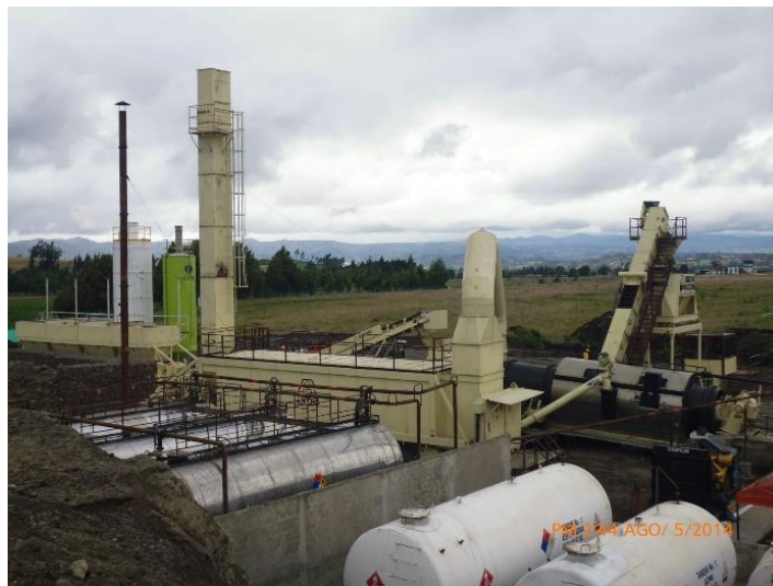
Figura 9. Vista general montaje Planta de Asfalto con unidad de dosificación en frío Fuente: SONACOL S.A.S. 2014
