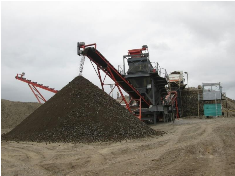
Figura 7. Vista General Planta de Trituración Fuente: SONACOL S.A.S. 2015
