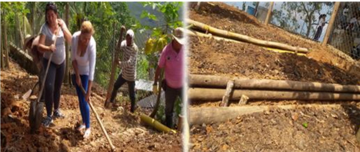
Figura 24. Adecuación del terreno y las eras I.E John F. Kennedy.
