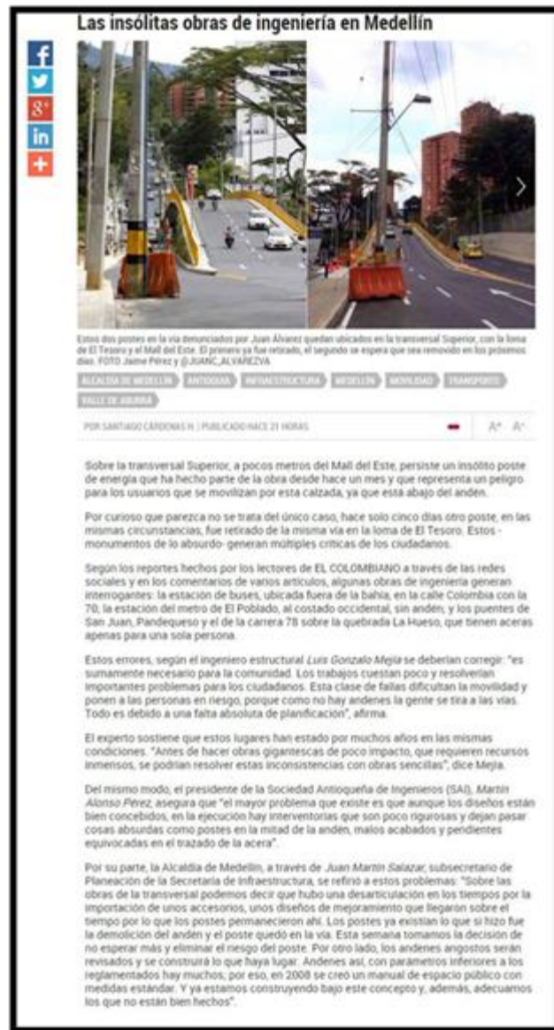
Figura 13. La fotografía de un tuitero denuncia obras de ingeniería mal ejecutadas, en El Colombiano. Fuente www.elcolombiano.com
