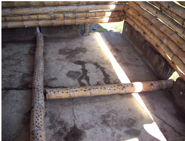
Figura 16. Sistema de aireación inferior.
