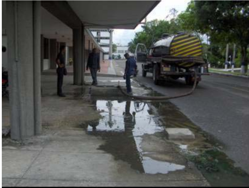
Figura 24. Evacuación de lodos pozo séptico Edificio Padilla
