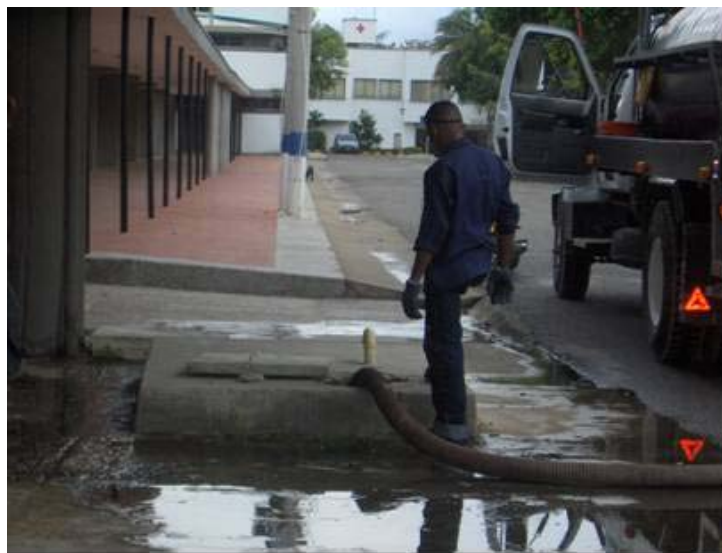
Figura 25. Evacuación de lodos pozo séptico Edificio Padilla
