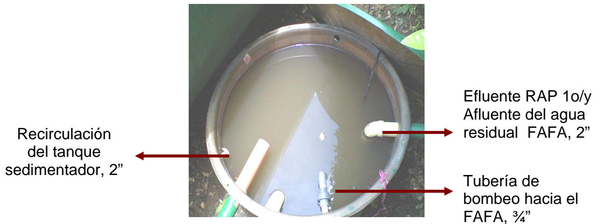
Figura 6. Planta tanque de bombeo
