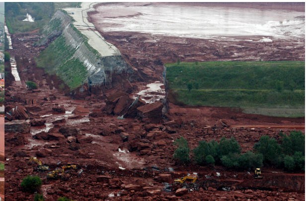
Gráfico 16. Fotografía aérea tomada el 05/06/2010 muestra la pared rota en el depósito de lodos rojos. Tomada de [24]
