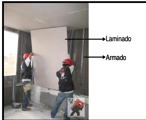
Figura 3. Actividades de Drywall
