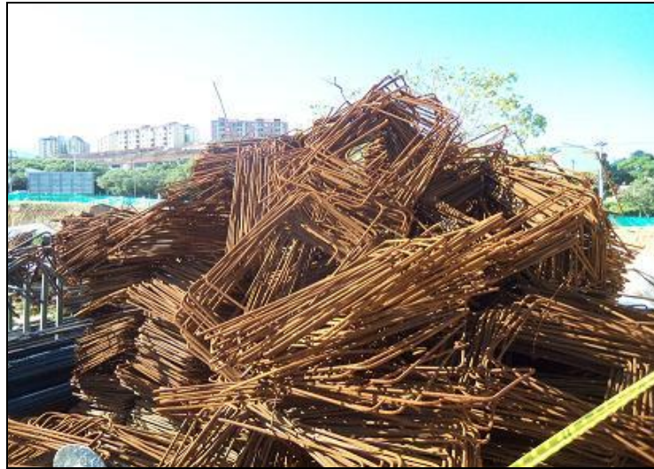
Figura 10. Falta Organización del Hierro
