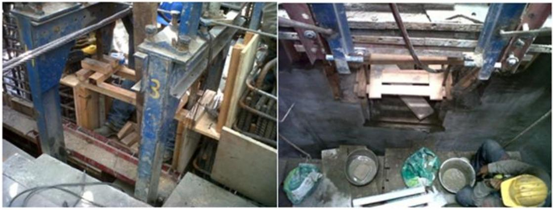
En la imagen se evidencia, la desaparición del muro central de la pila, este procedimiento se debió llevar a cabo, con formaleta de madera, ya que las secciones de la formaleta metálica no se ajustaban a la sección requerida, este proceso se realizó, bajo la supervisión y control de la interventoría.
