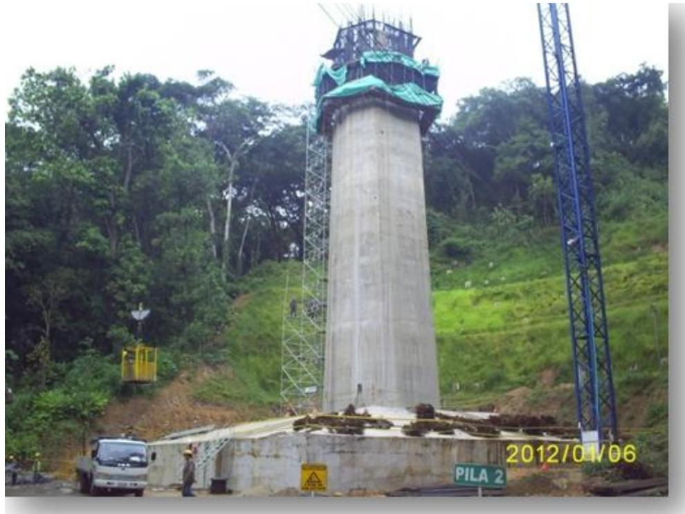
**Foto 23. Pila 2: 35.75 metros de altura**
