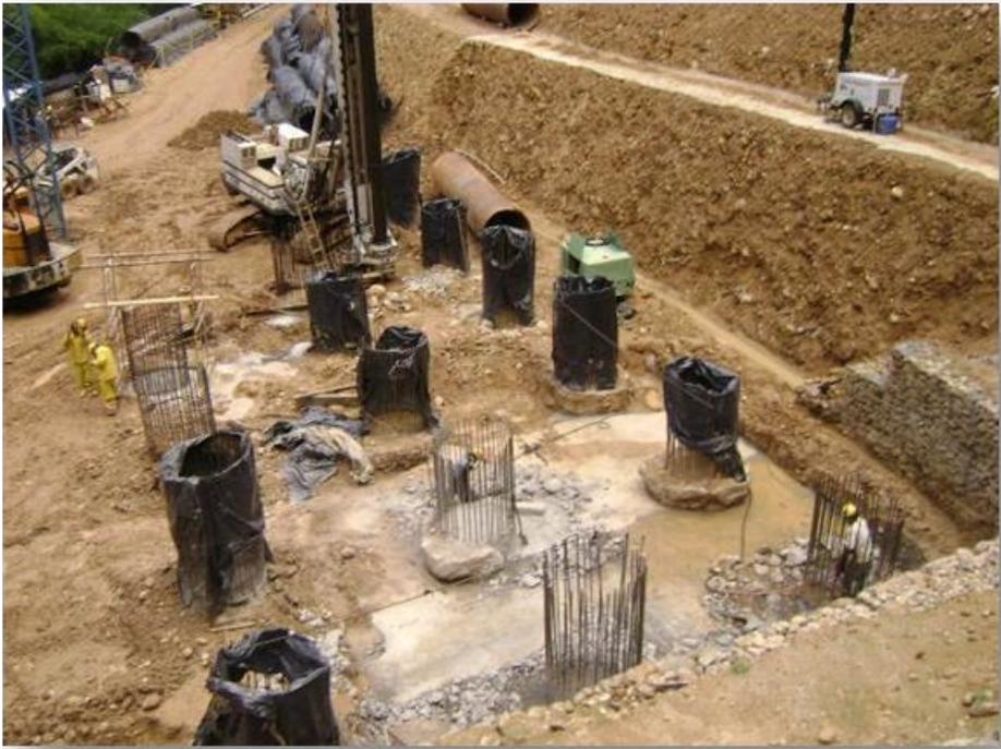
**Foto 27. Zapata Pila 3: Armado de acero (700 toneladas)**
