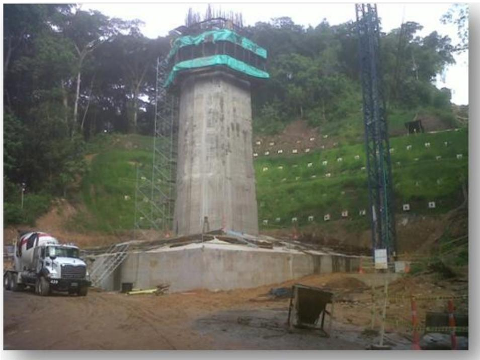
**Foto 22. Pila 2: 23.25 metros de altura**
