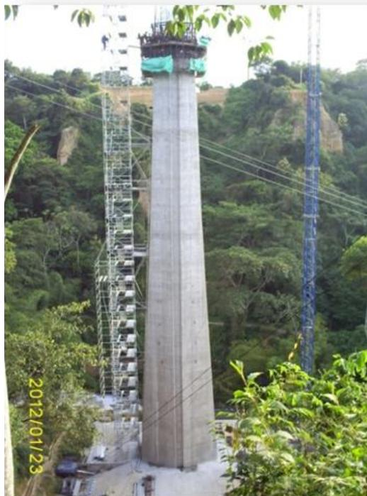
**Foto 34. Pila 3: 63 metros de altura, armado de acero de capitel.**
