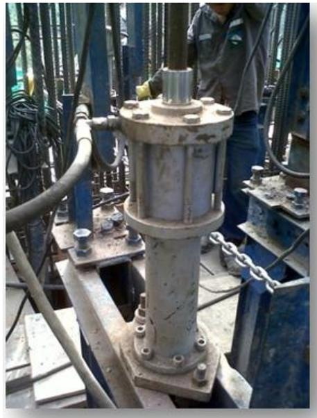
Los Gatos son los que impulsan la formaleta deslizante, por medio de un sistema hidráulico, trepando por una barra la cual queda embebida en el concreto. A dichos gatos se les realiza inspección, para verificar el avance uniforme de los mismos.
