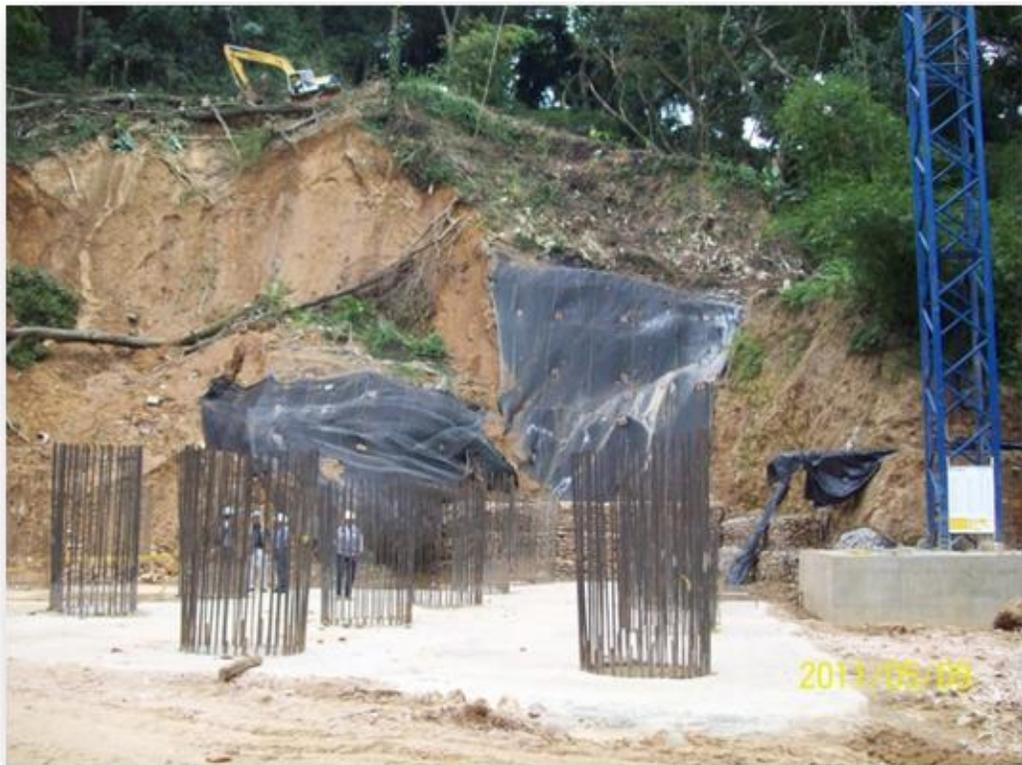
**Foto 18. Zapata Pila 2: armado de acero (700 Toneladas)**
