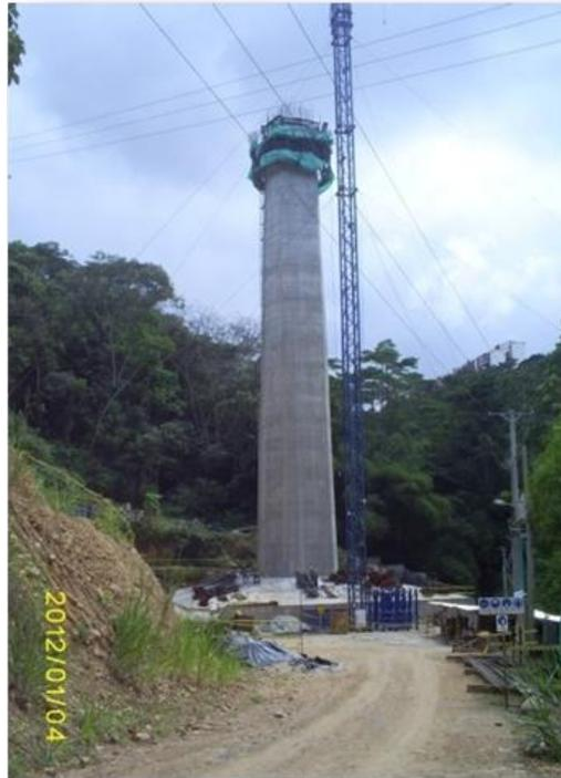
**Foto 33. Pila 3: 60 metros de altura**
