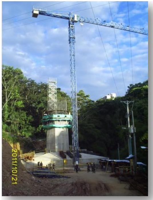
**Foto 32. Pila 3: 38 metros de altura**
