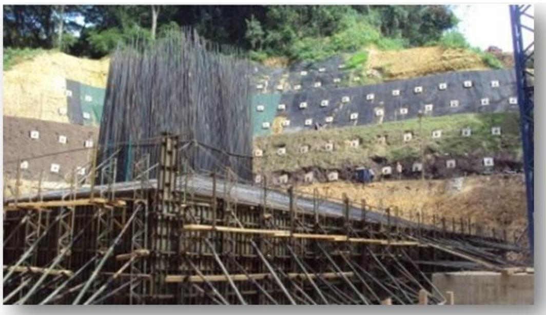
**Foto 20. Zapata Pila 2: después del concreto masivo de 2204 m3**
