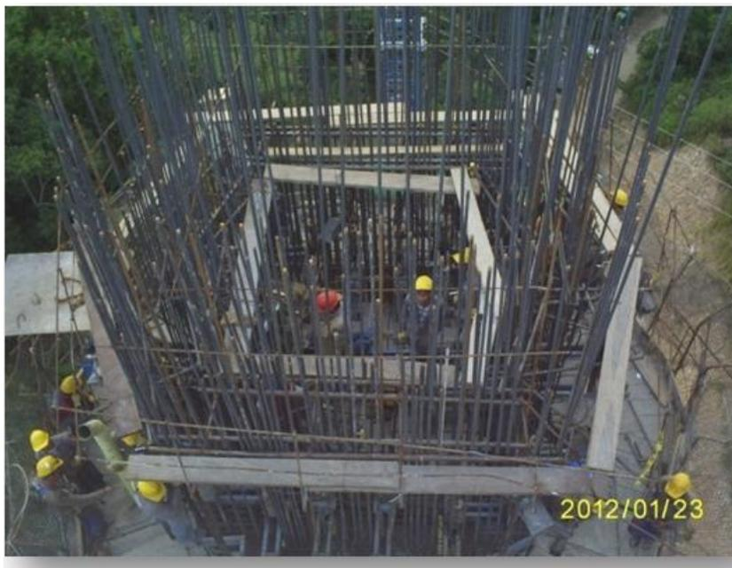
Durante el ascenso de la formaleta deslizante, la sección de la pila varia, así como se evidencia en la figura, este cambio está sujeto a los chequeos topográficos por parte de Interventoría, de tal forma que cumplan con las coordenadas de diseño y los recubrimientos de acero.
