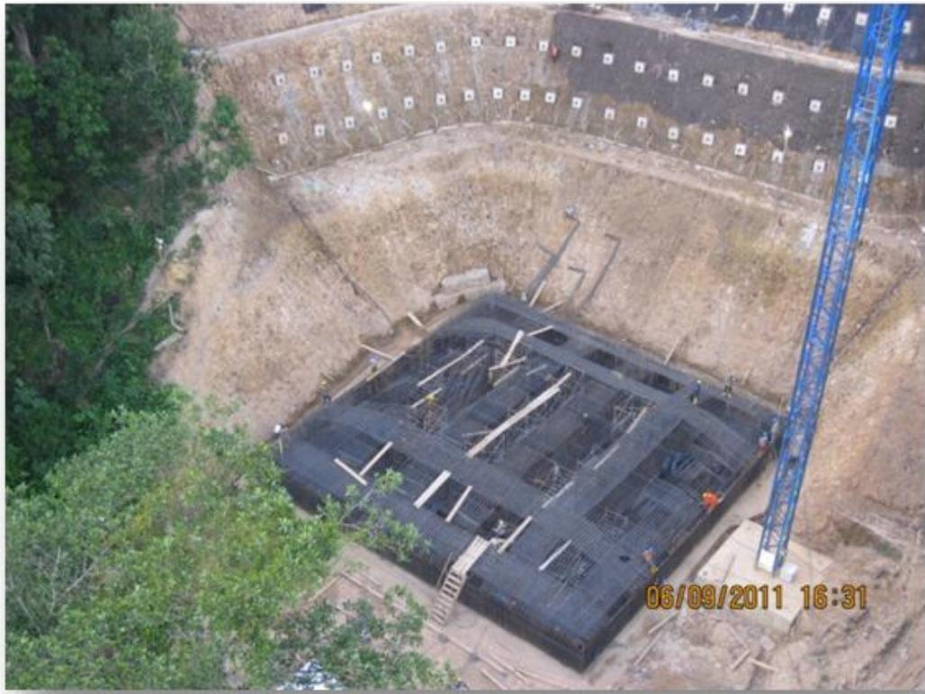
**Foto 19 Encofrado zapata pila 2: antes de concreto masivo**
