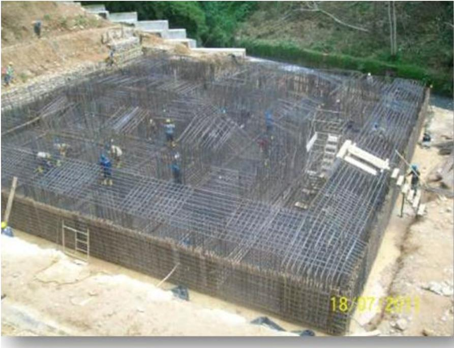
**Foto 28. Concreto masivo Pila 3: vasiado de 2222m<sup>3</sup> de concreto de 300 kg/cm<sup>2</sup>**
