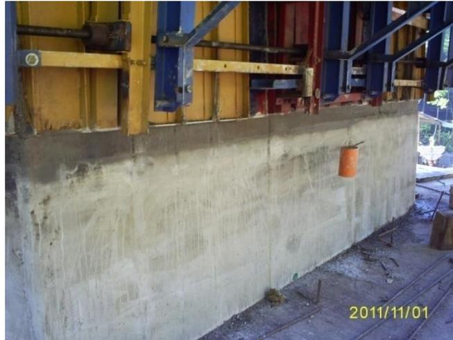
En el avance de deslizado se revisan los acabados internos y externos, para garantizar la armonía del concreto, ya que este queda a la vista. Los resanes son realizados con la misma pasta del concreto para garantizar, el mismo tono, y aquellos que requieren mayor volumen de resane, se es adiciona un producto toxement
