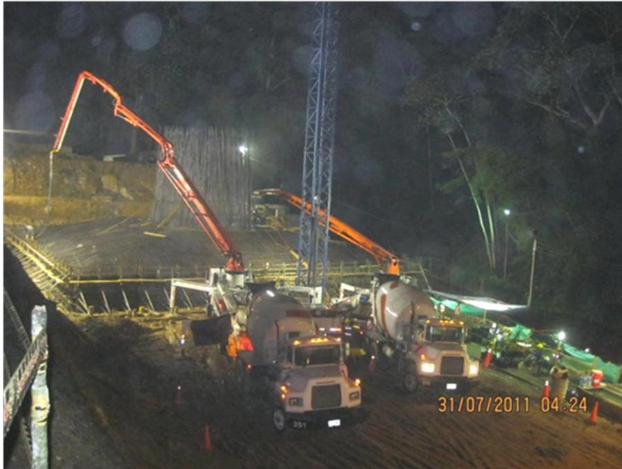
**Foto 29. Zapata Pila3 : dia despues de concreto masivo**
