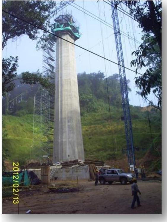
**Foto 25. Pila 2: 44.21 metros de altura, construcción de capitel**
