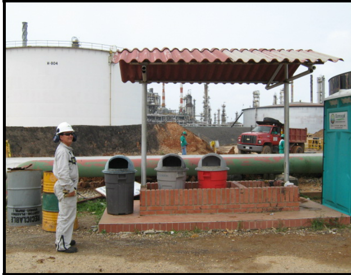
Figura 9. Punto Ecológico Casa Bombas 2 y 4
