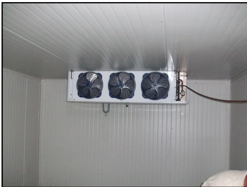
Figura 3. Instalación de Equipos Especiales.
