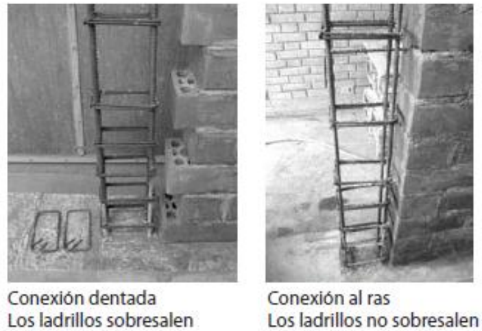
Figura 20. Conexión muro-columna
