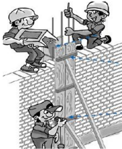
Figura 22. Encofrado y llenado de columnas
