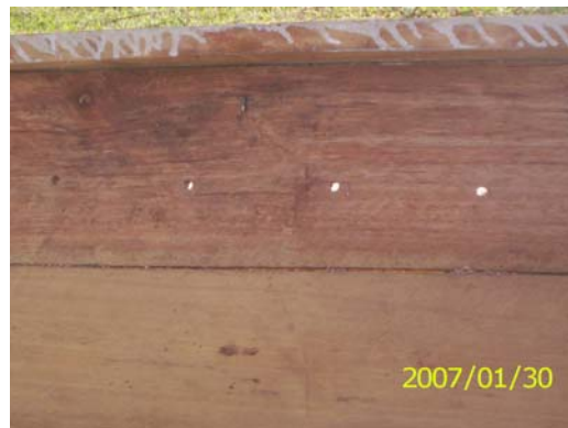
Figura 12. Orificios para drenaje en las pilas
