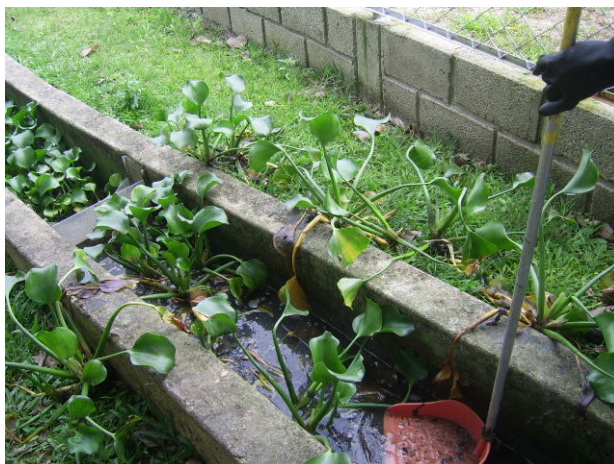
Figura 22. Limpieza de lodos en el sistema de tratamiento
