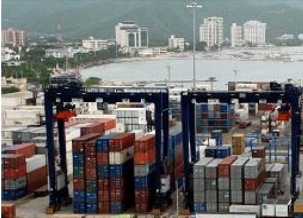
Fotografía 34. Grúas pórtico en el patio de contenedores. Fuente: www.smitco.com.co
