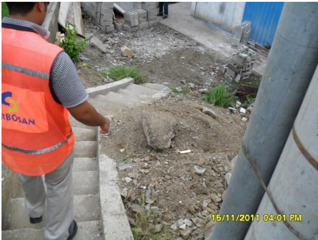
Fotografía 2. Seguimiento a obras
