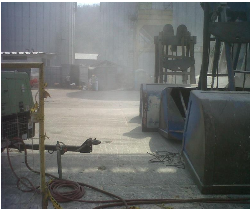
Fotografía 8. Material particulado generado por adecuación del muelle 4
