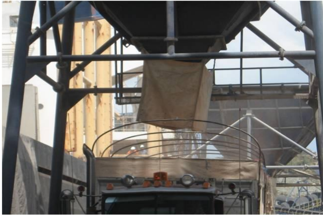
Fotografía 10. Uso de mangas para descargue de granel limpio
