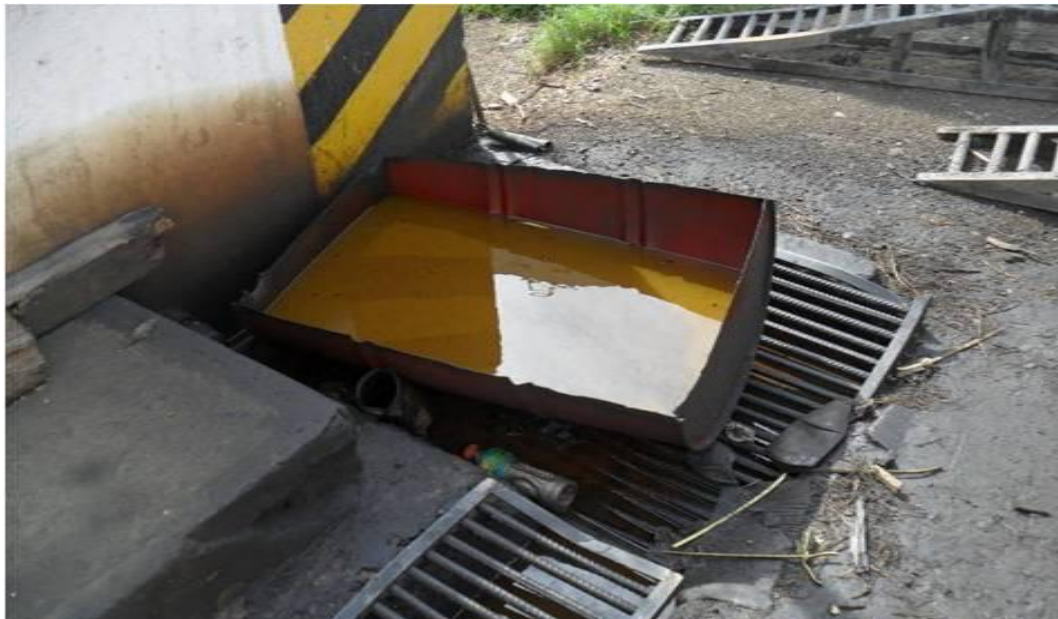
Fotografía 15. Aceite residual fuera de dique
