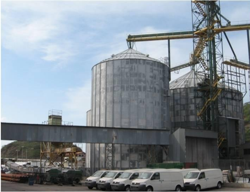
Fotografía 935. Silos de la SPSM
