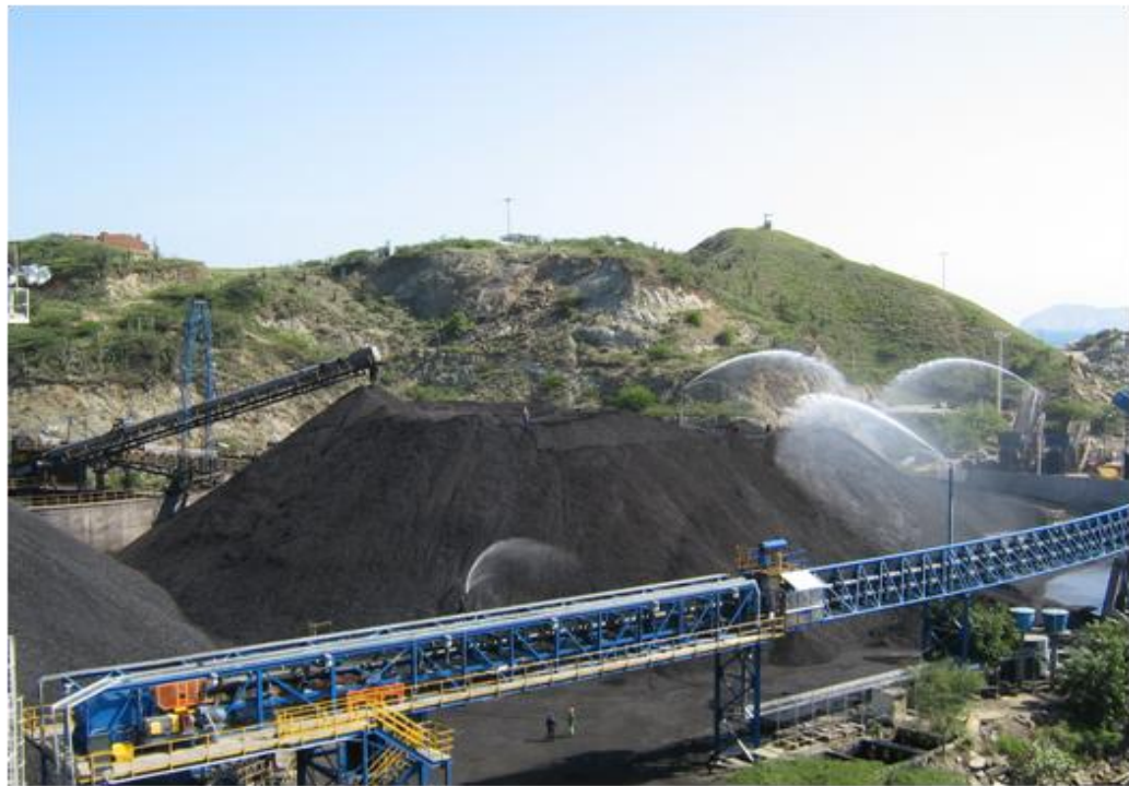
Fotografía 7. Riego de patios con sistema de cañones. Fuente: Presentación PMA SPSM
