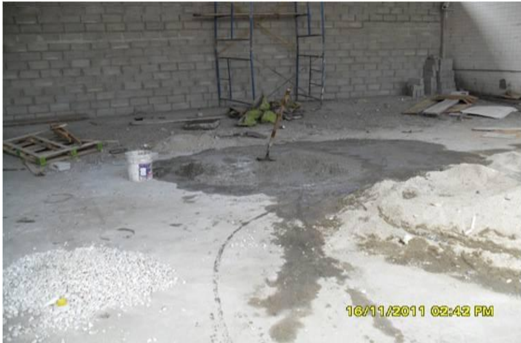
Fotografía 21. Mezcla de concreto directo sobre suelo
