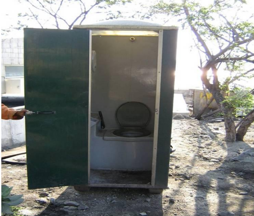
Fotografía 13. Batería sanitaria en mal estado de aseo y limpieza
