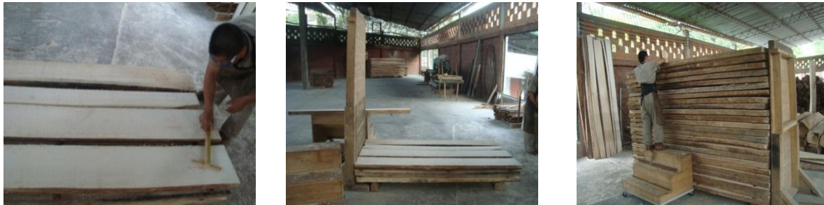
Fotografía 6. Proceso de armado de frentes de madera.
