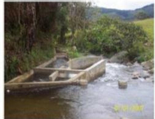
Detalle de las obras civiles de la presa y bocatoma de la Micro Central Hidroeléctrica. Enero 2007
