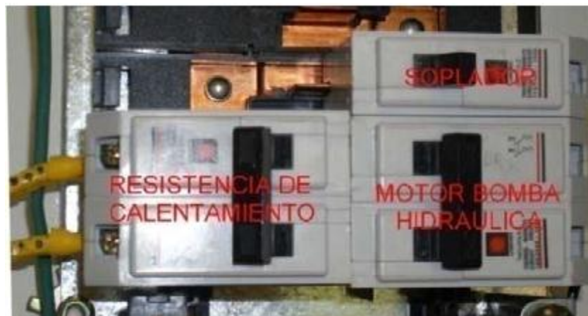
Figura 20: Tacos Termomagnéticos [15]
