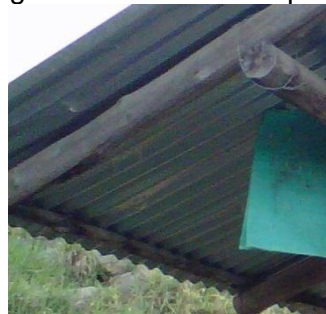
Imagen 2. Arreglo a techo de la compost de manzanito
