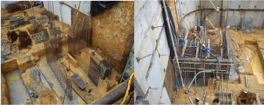
Figura 25 Armado y fundida de muros estructurales M19, M20, M21, M22
