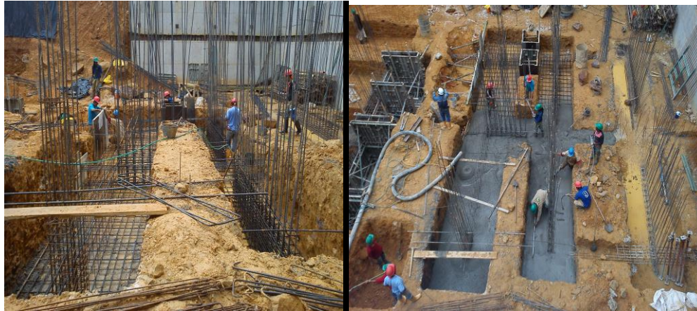
Figura 32 Armado y fundido zapatas eje E Y F con vigas de amarre 0,5m x 0,5m
