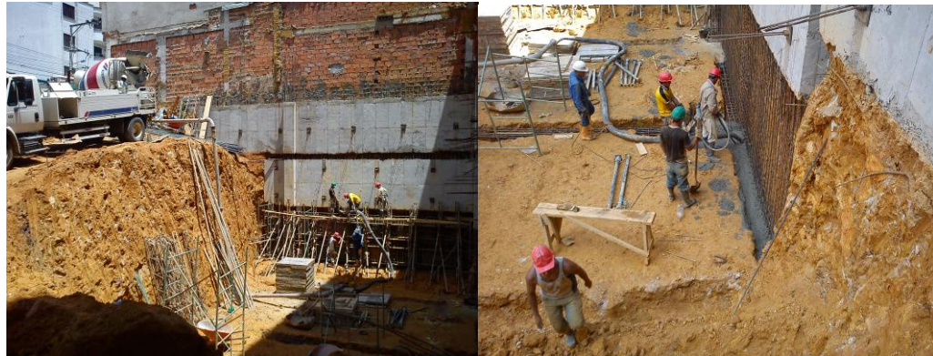
Figura 11 Fundida muro de contención MCONT-1 sótano -3 costado occidental y vigas de amarre costado norte de la estructura
