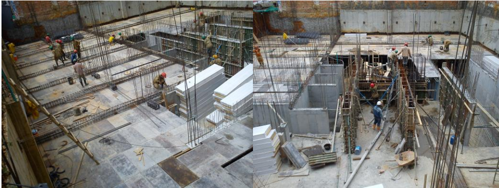
Figura 47 Armado placa 1 sótano -2 y fundida muros M2, M2A Y M3
