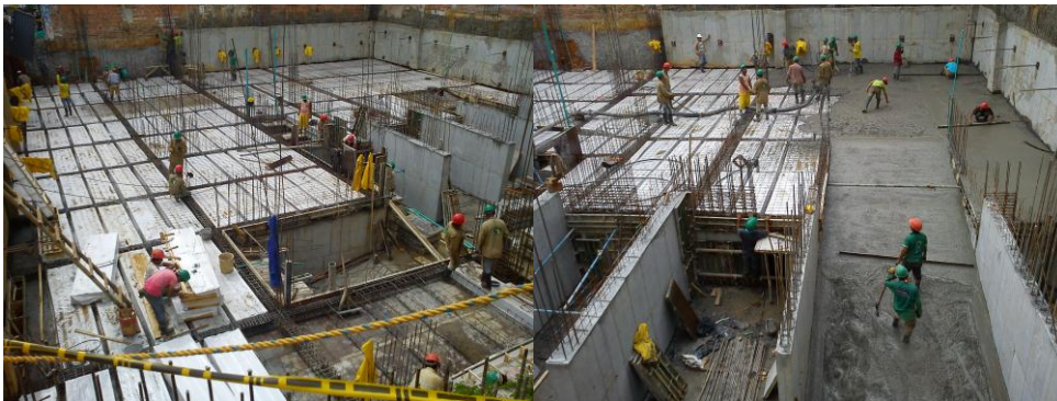
Figura 48 Fundida placa 1 sótano -2 y rampa entre muros M4 y M5
