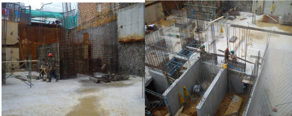
Figura 43 Armado muros M6, M7, M8, M9 Y muro MA
