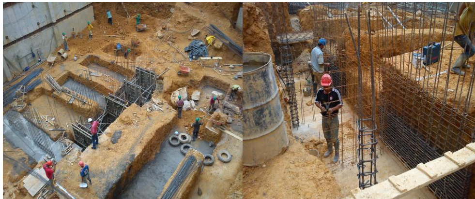
Figura 31 Excavación zapatas eje 7, 8 y armado encofrado M11, M13, M15, M17.
