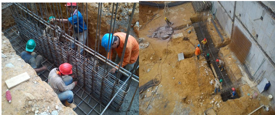
Figura 27 Armado de la zapata eje G y muro M5
