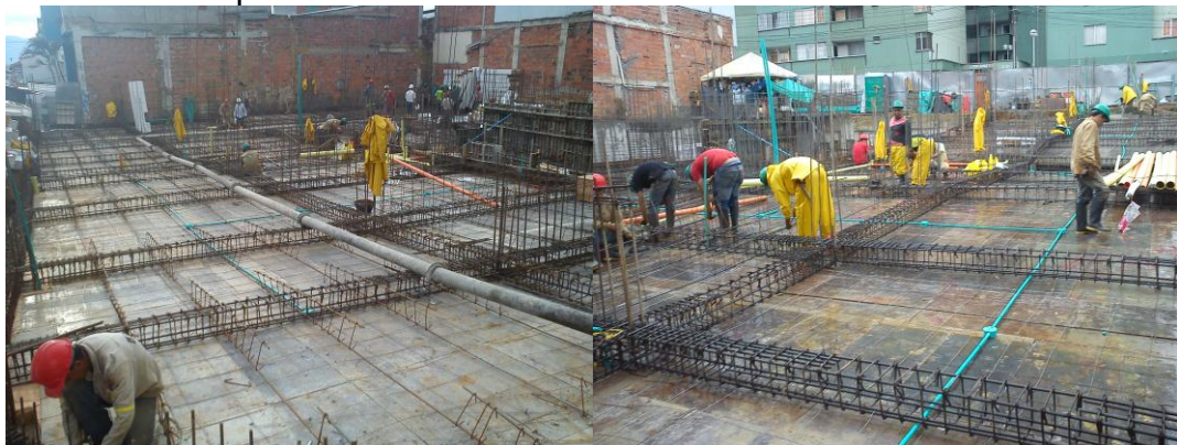
Figura 51 Armado placa cubierta 1 sótano - 1.
