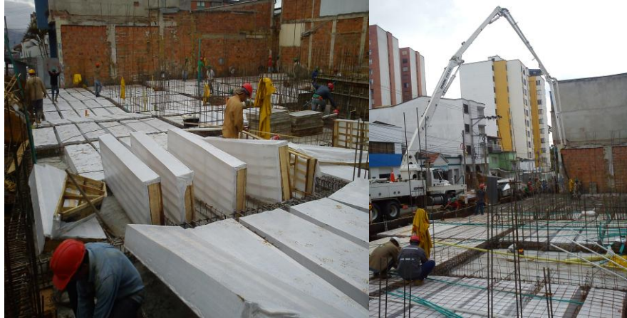
Figura 52 Posición de casetones y fundida placa cubierta 1 sótano - 1.
