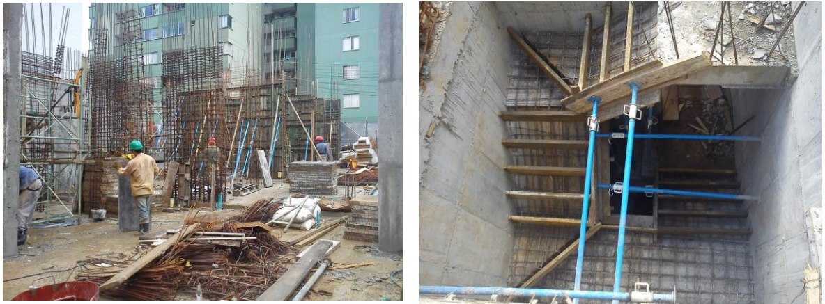
Figura 55 Armado muros primer piso y escalera entre piso 1 y sótano -1
