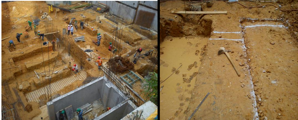
Figura 30 Excavación zapatas eje E, F, 6, 7, 8 armado zapata eje 5
