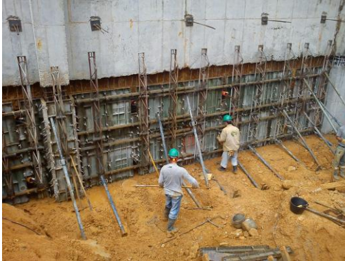
Figura 3 Encofrado Muro de contención MCONT -1 sótano -2 costado occidental
