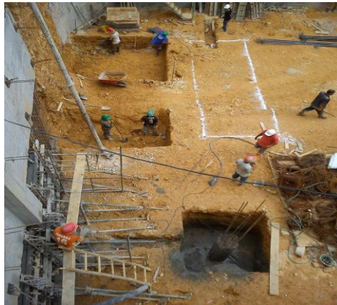
Figura 22 Demarcación y excavación zapatas ubicadas en los ejes (1-2) y eje 4 del terreno
