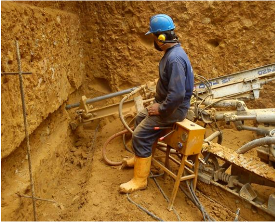
Figura 4 Perforación de anclajes en costado Sur de la obra sótano -2
