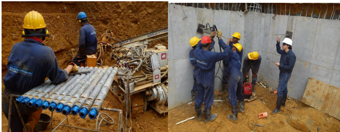
Figura 61 Verificación en la etapa de perforación y del tensionamiento de anclajes
