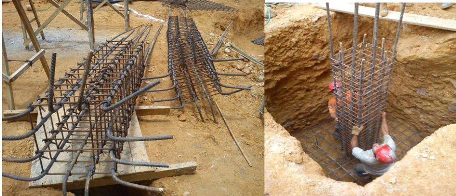
Figura 21 Armado columnas (1-E), (3-E), (3-C), (1-C) y (1-B).
