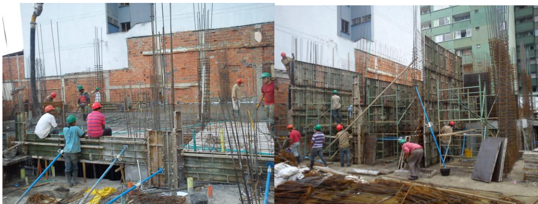
Figura 54 Placa cubierta 2 sótano – 1 y fundida muros M3, M4 y M5
