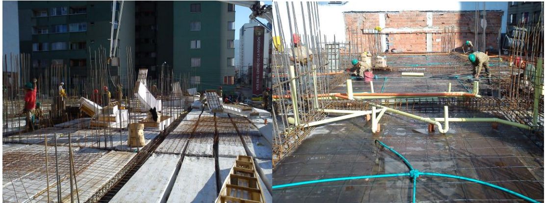
Figura 58 Armado redes sanitarias, eléctricas y acero placa cubierta piso 1
