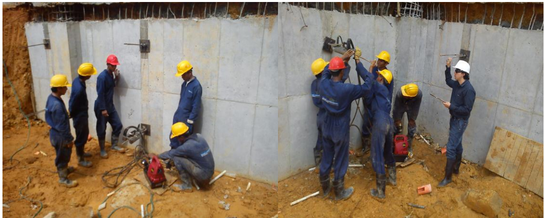
Figura 5 Tensión de anclajes MCONT-1 sótano -2 costado Occidental
