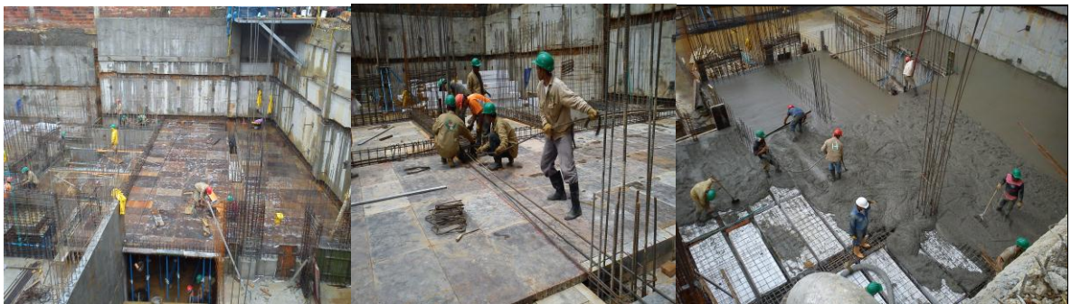
Figura 44 Entablarado, armado y fundido placa 3 S-3
