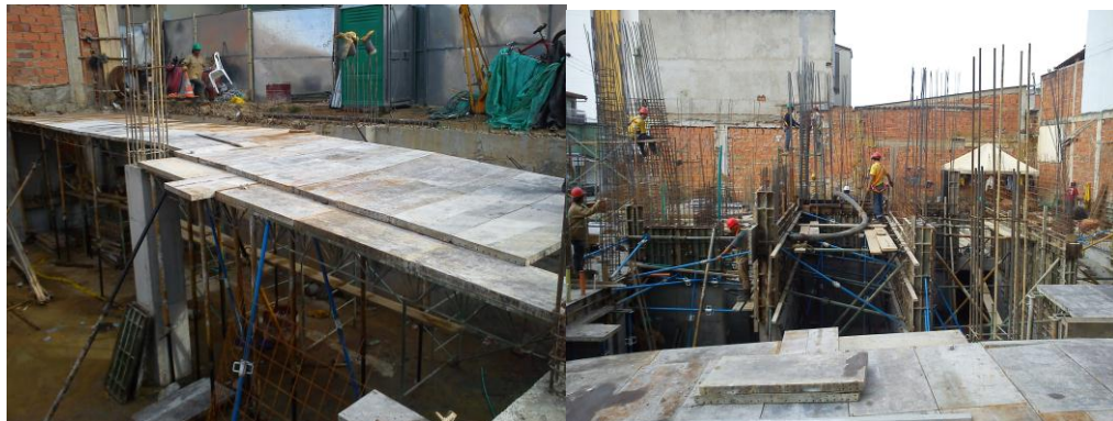
Figura 53 Placa cubierta 2 sótano – 1 y fundida muros MA, M2, M2A, M3, M4
