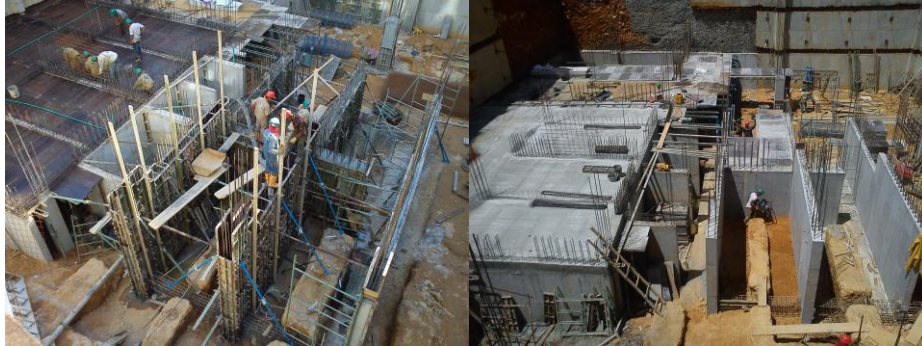
Figura 40 Fundida muros MA, M2, M2A, M3 e inicio armado placa 2 s-3
