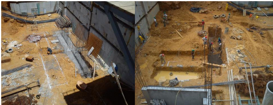
Figura 29 Excavación zapata eje 5, eje 6, eje F y foso del ascensor
