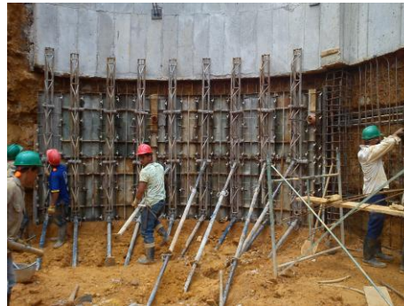
Figura 6 Encofrado y apuntalado MCONT -3 sótano -2 costado sur entre los ejes (A-B) y eje (1-4)
