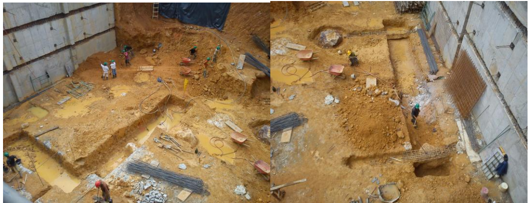
Figura 26 Excavación Foso ascensor y zapata eje G de la estructura
