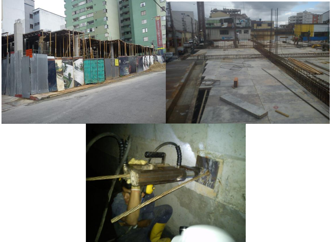
Figura 57 Entablado placa cubierta piso1 y des tensionado de anclajes
