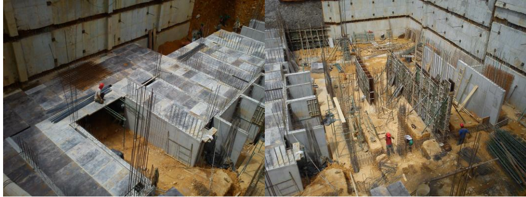
Figura 38 Entablarado placa cubierta 1 sótano -3 y armado y encofrado muros MA, M2 , M2A, M3 Y M4.
