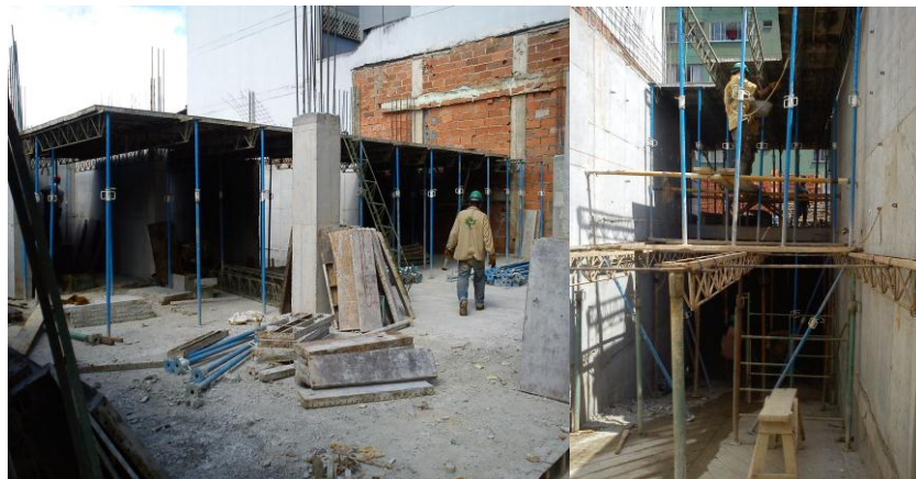
Figura 56 Entablarado placa cubierta piso 1
