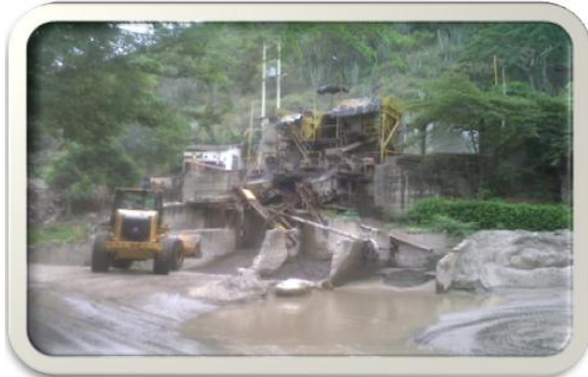
Figura 42. Trituración de material (trituradora Avendaño Sáenz)
