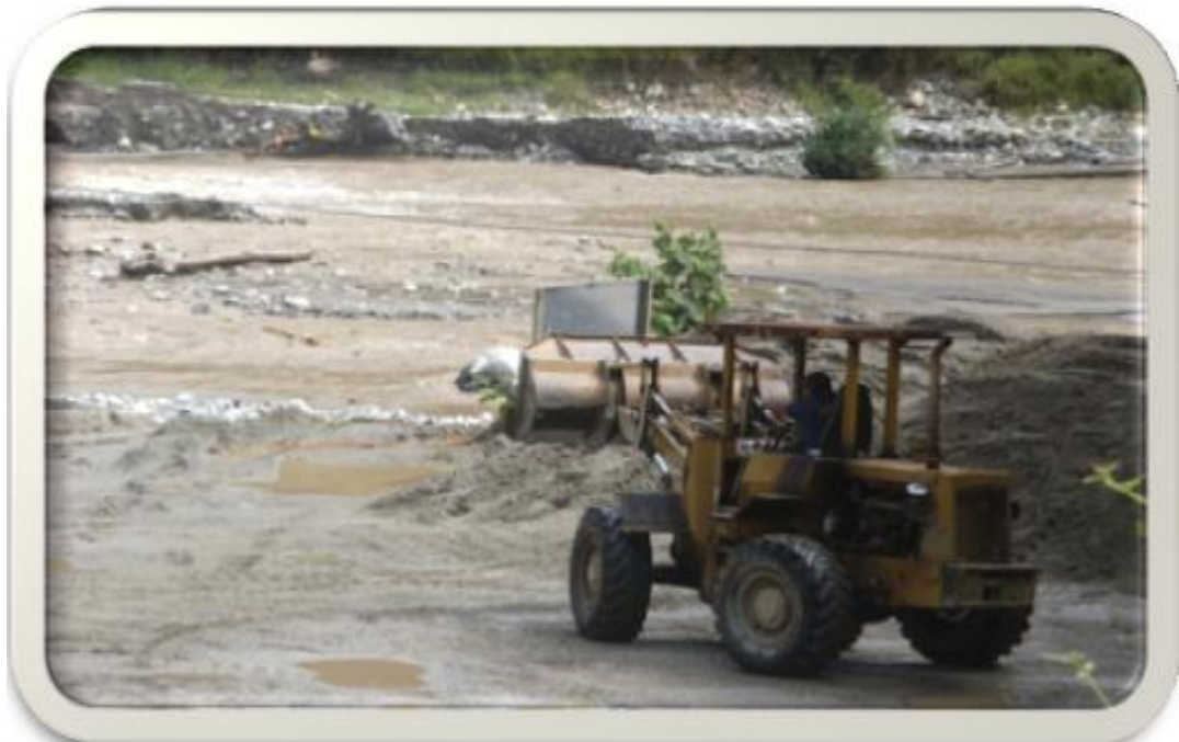
Figura 41. Extracción de material trituradora La Fortuna
