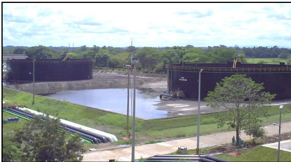
Fotografía 5. Panorámica Estación Vasconia.
